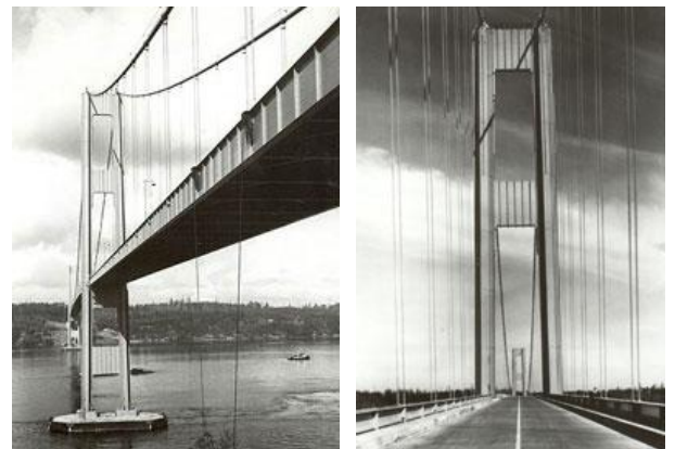
Figura 2: Fotografias da ponte de Tacoma Narrows: detalhes do tabuleiro e torre (Scott, 2001).
