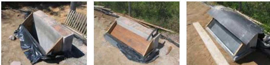
Figura 26: fotos da montagem e forma final da chaminé solar
