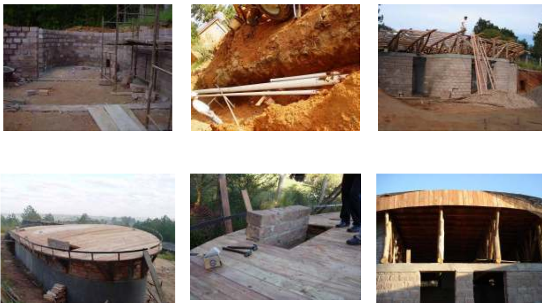
Figura 24: fotos da construção do protótipo (em ordem: construção das paredes, tubos enterrados, estrutura da cobertura, assoalho da cobertura, estrutura da chaminé solar e fechamento da cobertura)
