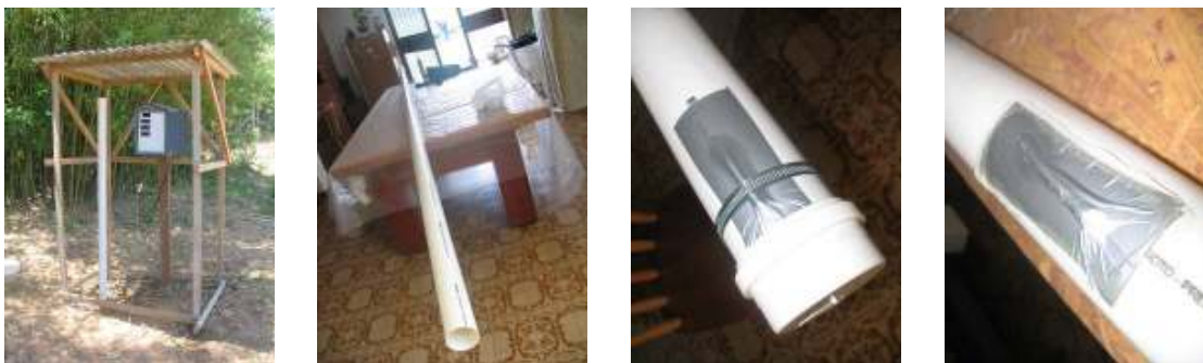
Figura 46: fotos da instalação dos sensores de temperatura e umidade relativa e de temperatura do solo
