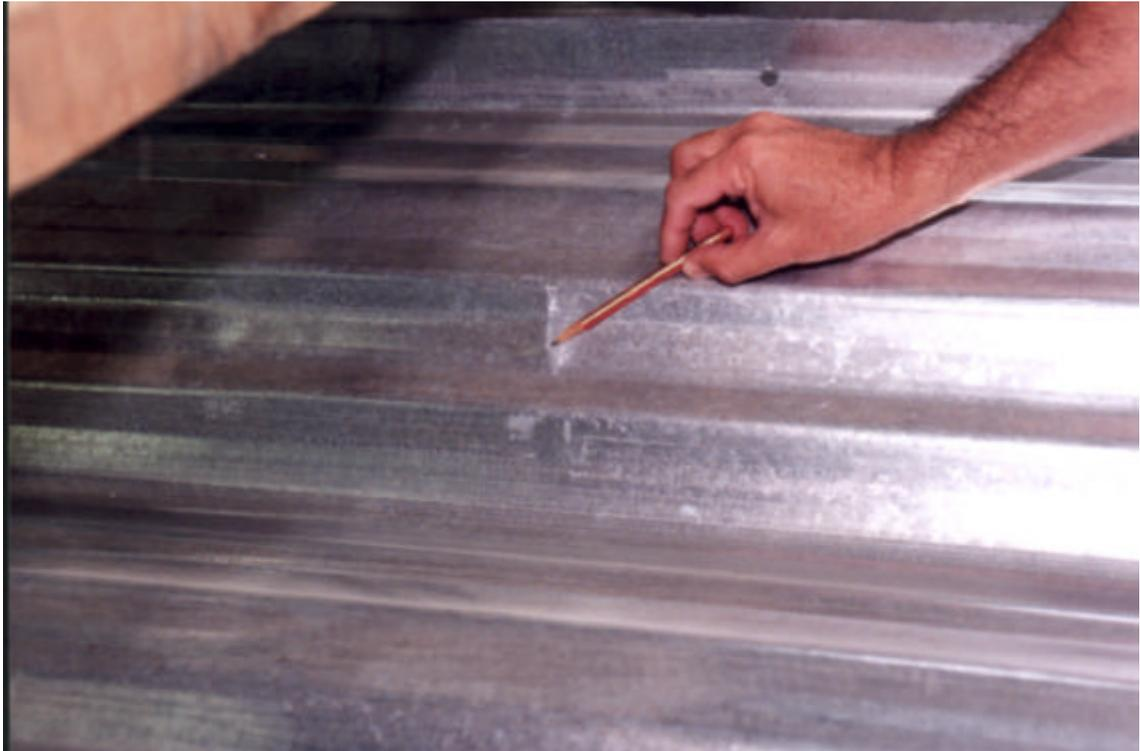
Figura 4.32 - Detalhe, na metade da telha direita, próximo do ponto P13, de um leve dobramento localizado, decorrente do processo de perfilação, observado antes da utilização da telha nos ensaios. Esse tipo de dobramento foi observado em outros locais da telha direita e também nas demais telhas (central e esquerda) do espécime 2.
