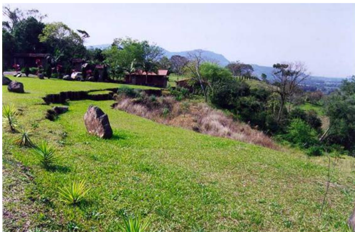
Foto 4.16 – Rupturas retro-progressivas que avançam em direção à rodovia e às moradias.
