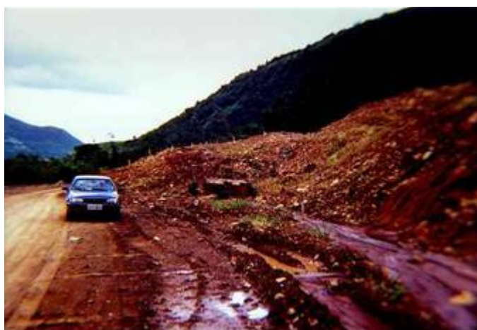
Foto 4.4 – Ruptura circular em colúvio de grande espessura no km 103, RS-486.
