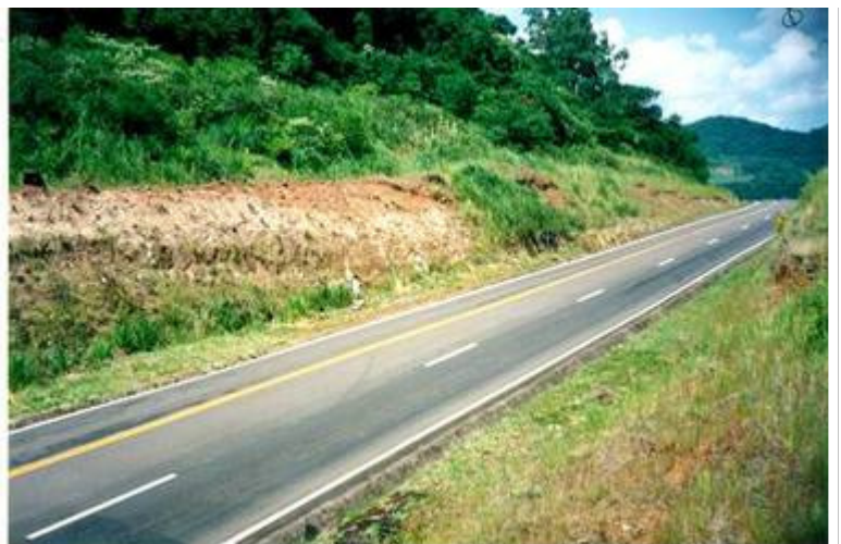
Foto 4.7 – Encosta nordeste do talude de Teutônia – RST-453.
