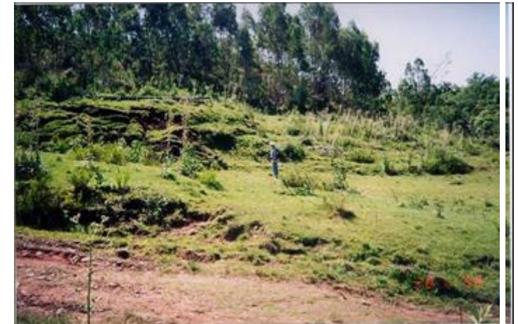
Foto 7.13 – Frente do escorregamento próximo ao arroio.
