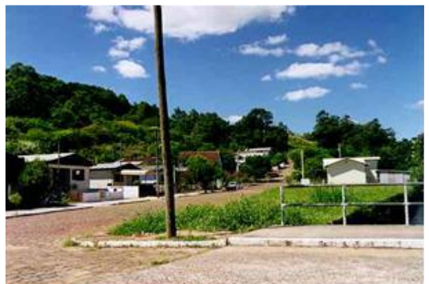
Foto 4.14 – Detalhe da parte inferior da encosta na área urbana de Santa Cruz do Sul.
