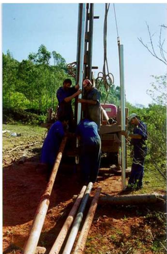
Foto 7.53 – Colocação do tubo guia do inclinômetro – I3
