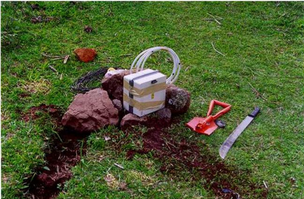
Foto 7.51 – Instalação do sistema de monitoramento no piezômetro 4.
