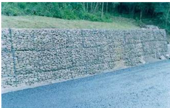
Foto 4.3 – Estrutura de contenção executada no km 104 + 500 para conter os deslocamentos (RS-486).
