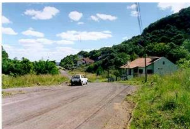
Foto 4.13 – Detalhe da parte superior da encosta na área urbana de Santa Cruz do Sul.
