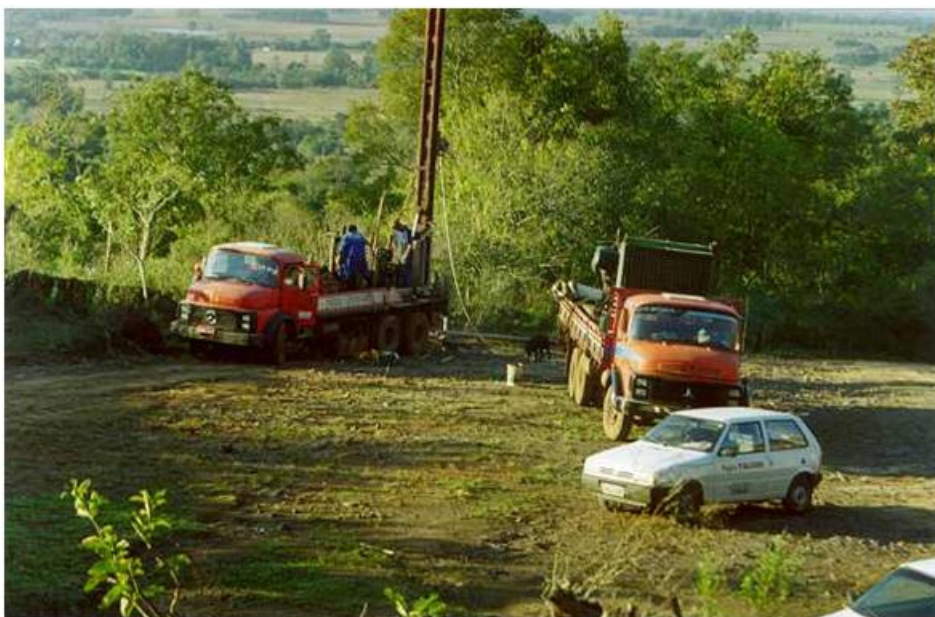
Foto 7.52 – Equipamento roto-pneumático utilizado para execução dos furos.
