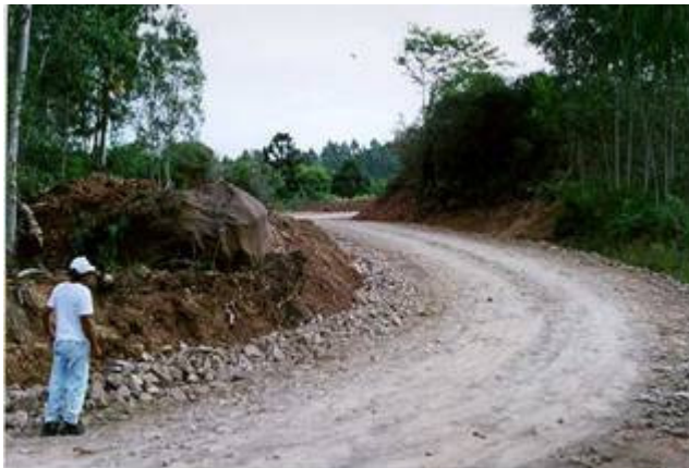
Foto 7.21 – Colúvio com blocos de rocha vulcânica (derrame 1).
