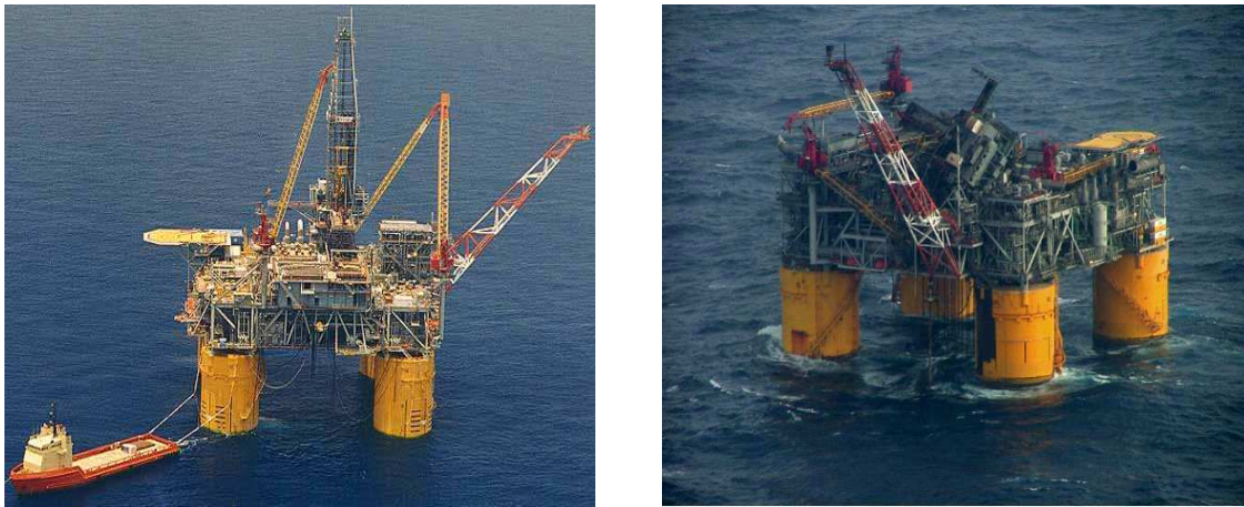
Figura 1.1: TLP antes (esquerda) e depois (direita) da passagem do furacão Katrina.
