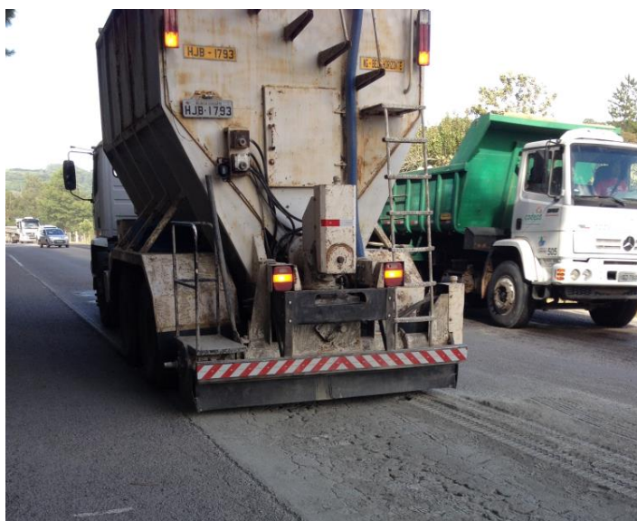
Figura 4: Distribuição do cimento através de distribuidor de aglomerante hidráulico
