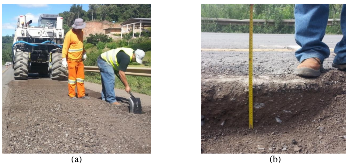
Figura 16: Realização da (a) coleta com auxílio da máquina recicladora e (b) medição da espessura coletada da camada
