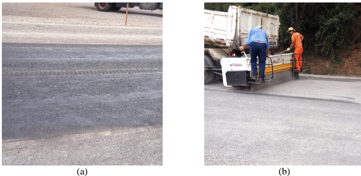
Figura 9: Proteção da camada reciclada através de (a) pintura de cura e (b) salgamento
