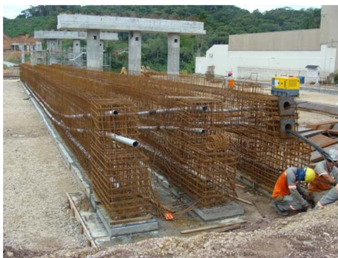
Figura 5: Montagem de Longarinas Protendidas
