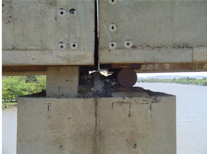
Figura 25: Aparelhos de apoio de concreto com placa de chumbo e rolete de aço (vínculos de 2º e 1º ordem, respectivamente)
