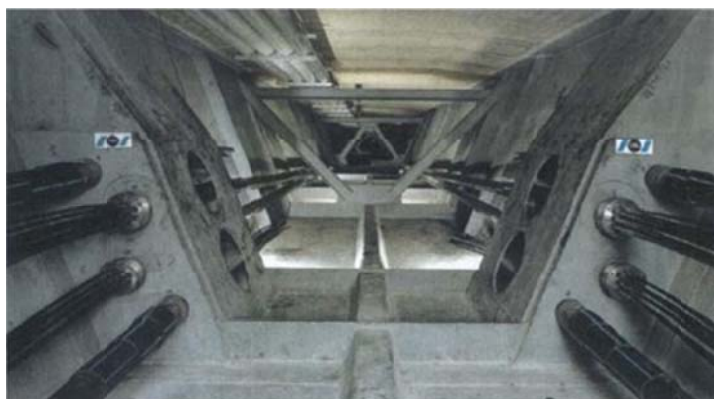
Figura 91: Viaduto Bois de Rosset , Suíça (NELSEN, 2013)
