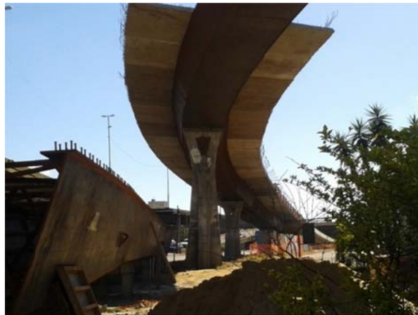
Figura 42: Viaduto em estrutura mista de seção caixão
