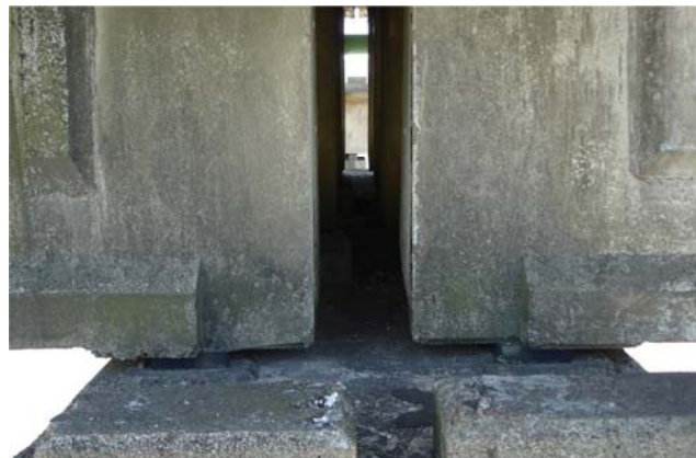
Figura 27: Aparelhos de apoio em neoprene fretado (vínculo elástico). Equivalem no modelo matemático a vínculos elásticos ou vínculos de 2º ordem
