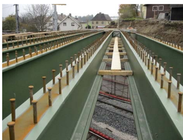
Figura 12: Conectores de cisalhamento Stud Bolts soldados
