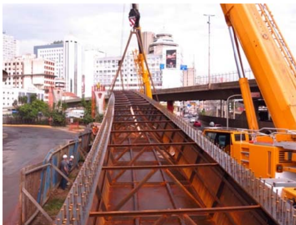
Figura 21: Içamento da seção sobre pilares
