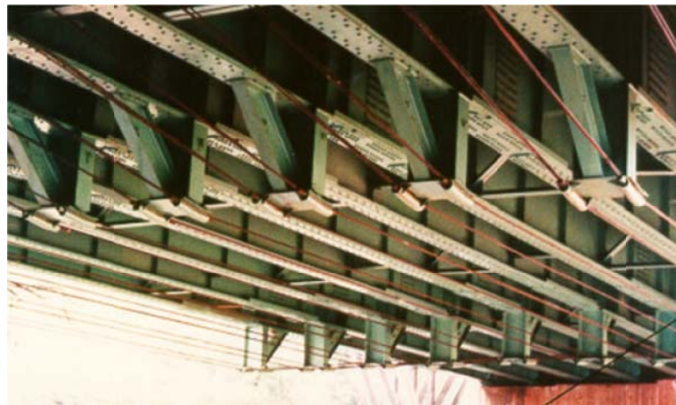
Figura 2: Protensão externa de reforço – Ponte Condet (Indonésia)
