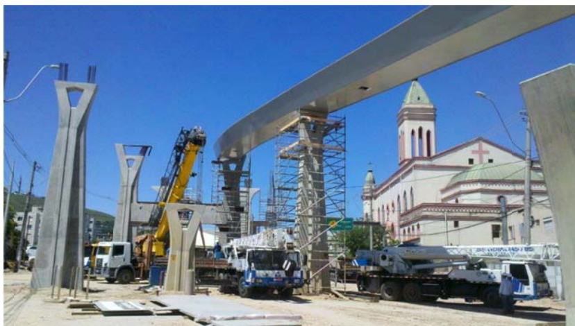
Figura 16: Trabalhos no viaduto sobre Av. Bento Gonçalves (Porto Alegre)
