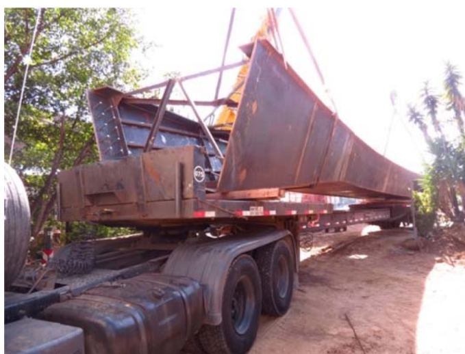
Figura 20: Viaduto Av. Julio de Castilhos – içamento
