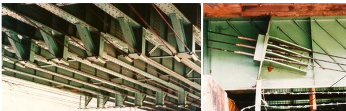
Figura 51: Ponte Condet após reforço com protensão externa (NELSEN, 2013)
