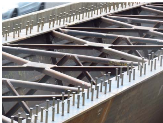
Figura 86: Posicionamento dos conectores sobre as mesas superiores da seção caixão
