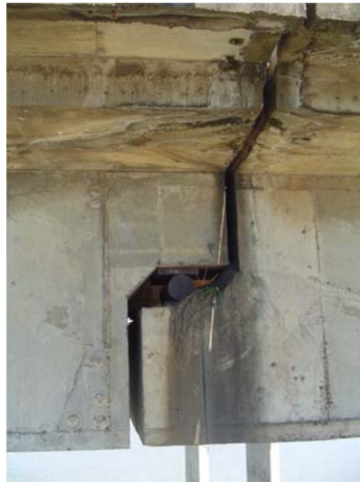
Figura 26: Dente Gerber (superestrutura)
