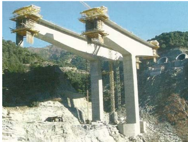
Figura 7: Construção da Rodovia Egnatia (Grécia) – balanços sucessivos (TZAVEAS; GAVAISE, 2010)
