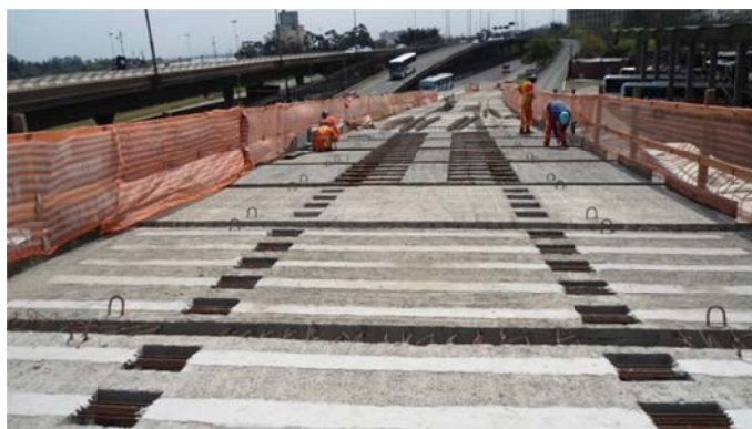
Figura 22: Lajes pré-moldadas com rebaixos (furos retangulares) para encaixe e ligação com os conectores de cisalhamento. Rebaixos para posicionamento da armadura negativa de continuidade (ao fundo)
