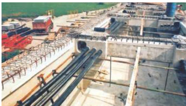
Figura 89: Bainha mestre em PEAD preenchida com nata de cimento, para acomodação de várias cordoalhas em protensão externa (PROTENDE)
