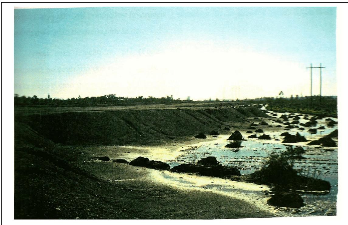
Figura 45: Detalhe do depósito CH 20, onde observa-se a ausência de cobertura vegetal na área localizada entre o talude de deposição dos rejeitos e a canaleta de proteção.
