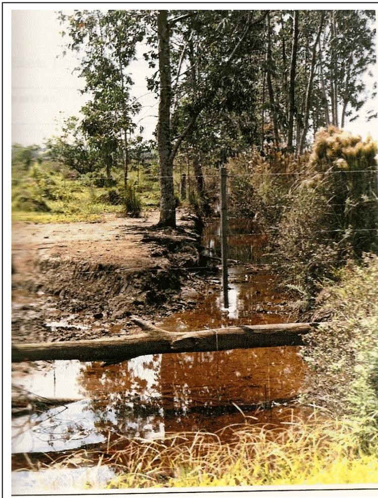
Figura 44: Detalhe das canaletas de proteção construídas no depósito CH 20 - encontro das canaletas leste e oeste, onde observa-se a coloração vermelho-alaranjada da água captada.
