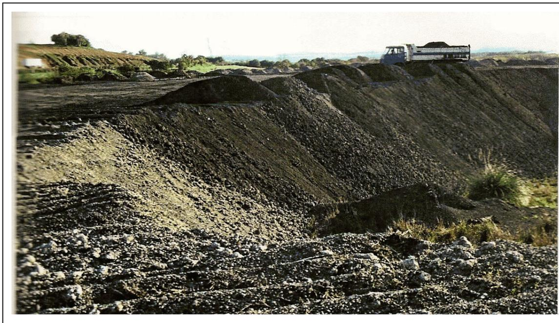
Figura 35: Área de descarte das cinzas grossas - depósito SJ 02.
