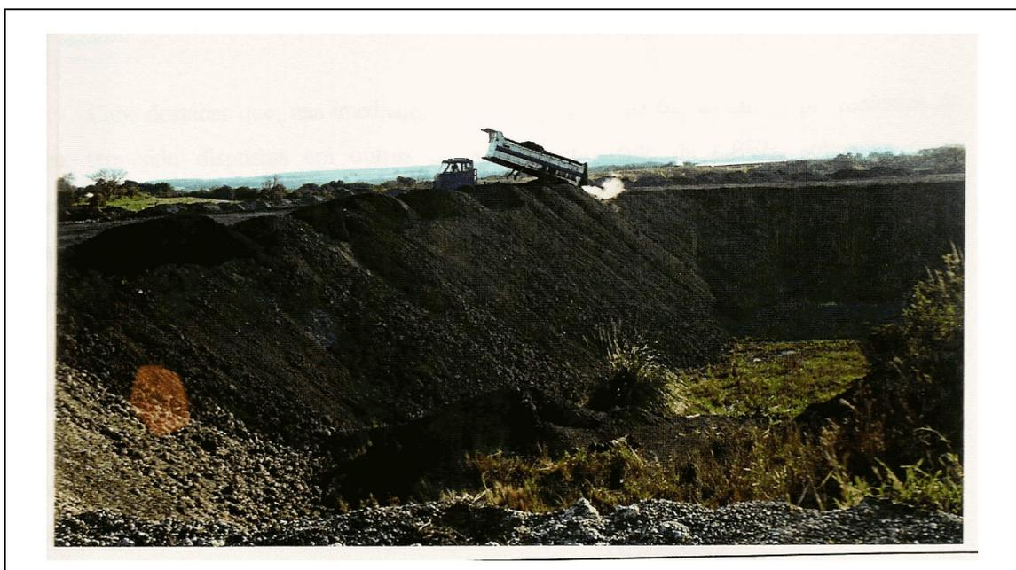
Figura 36: Detalhe da área de descarte das cinzas grossas - depósito SJ 02, onde observa-se a altura de aproximadamente 4 metros da bancada.
