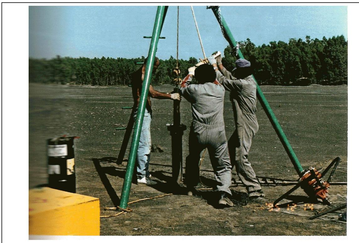
Figura 22: Operação de sondagem utilizando sonda à percussão.
