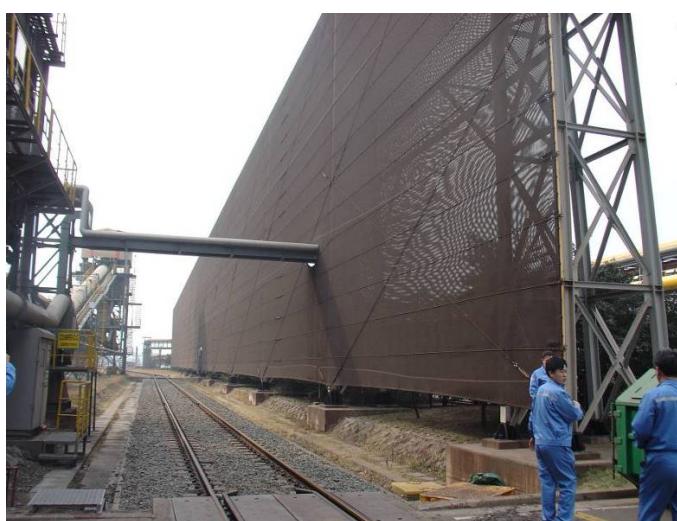
Figura 2.8 – Telas instaladas em POSCO, Coreia do Sul. Fonte: POSCO (2005).
