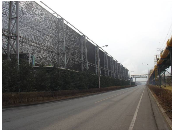
Figura 2.9 – Telas instaladas em POSCO, Coréia do Sul. Fonte: POSCO (2005).
