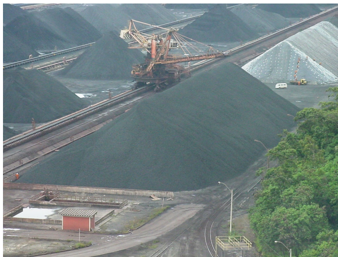
Figura 1.1 – Visão de um pátio de armazenamento de carvão.
