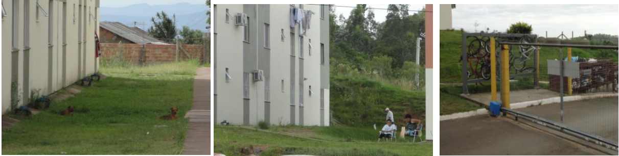
Figura 38 - Áreas comuns EHIS 1: (a) presença constante de animais abandonados; (b) pessoas convivendo nos espaços abertos; (c) à direita, o bicicletário e as lixeiras novas instaladas pelo condomínio (02/03/2015)
