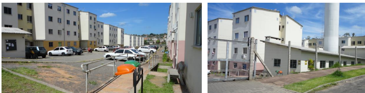
Figura 49 - Entrada EHIS 3 - vistas interna e externa (23/01/15)
