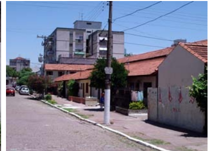
Figura 3.22: Acesso rua Olinto de Oliveira
