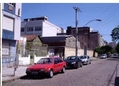
Figura 4.24: Edificações com manutenção ruim na rua Jacinto Gomes
