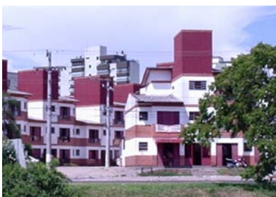
Figura 4.71: Vista da fachada do Condomínio dos Anjos
