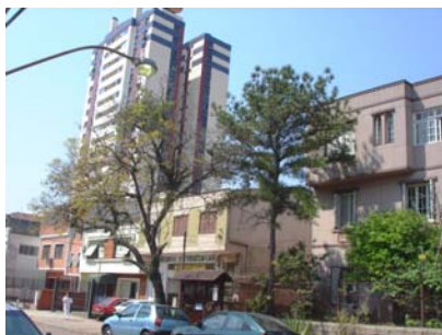
Figura 4.112: Edificações de estilo e alturas variadas na rua Domingos Crescêncio
