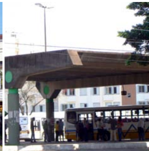
Figura 4.132: Terminal João Pessoa
