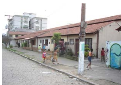
Figura 4.10: A falta de manutenção das calçadas no Jardim Planetário
