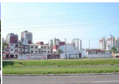
Figura 4.72: Vista do Condomínio dos Anjos e entorno imediato
