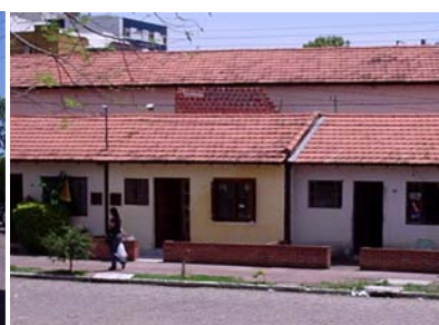
Figura 4.25: Edificações do Jardim Planetário se diferenciam do entorno pelo estilo, altura e manutenção
