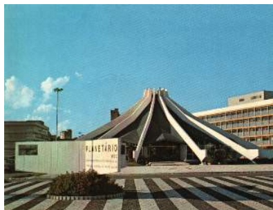
Figura 3.11: Vista do acesso ao Observatório Planetário
