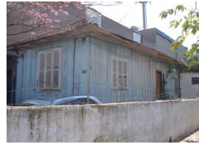
Figura 3.42: Edificação popular na rua Leopoldo Bier
