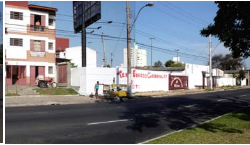
Figura 4.57: Condomínio dos Anjos e a precariedade do entorno
