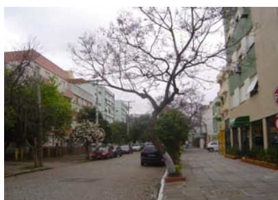
Figura 4.23: Edificações com manutenção regular na rua Laurindo
