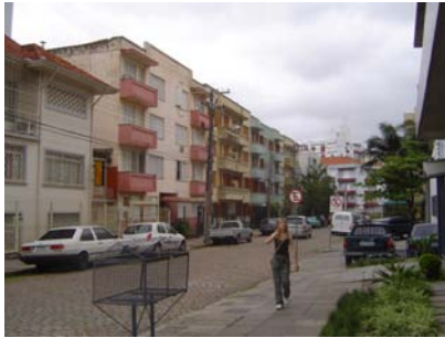
Figura 4.18: Edificações protomodernas na rua Eng. Vespúcio de Abreu
