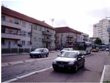
Figura 3.40: Edificação multifamiliar na av. Bento Gonçalves
