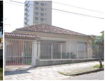
Figura 4.58: Calçadas bem mantidas – rua Eça de Queiroz
