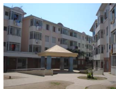
Figura 3.49: Área interna do Condomínio Princesa Isabel
