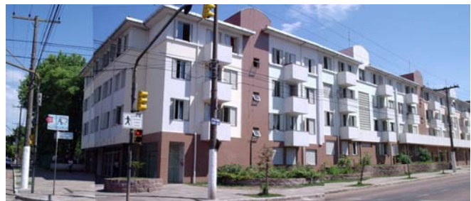
Figura 3.44: Vista do Condomínio Princesa Isabel a partir da esquina da av. Princesa Isabel com av. João Pessoa
