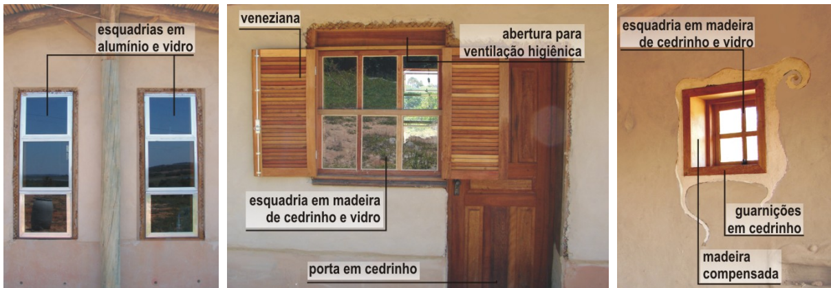
Figura 29: subsistema de esquadrias (Fotos: outubro 2006)
