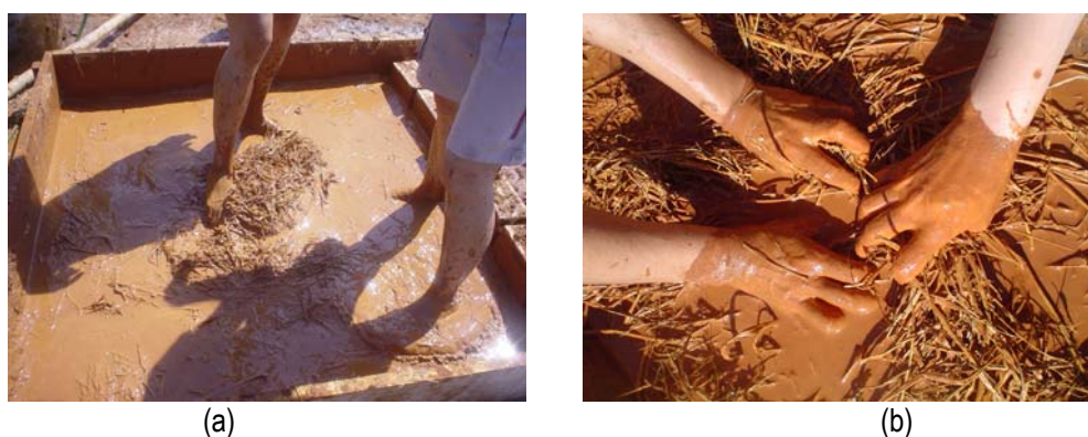
Figura 36: preparação da mistura para preencher as imperfeições das paredes de fardos de palha (Fotos: (a) Ingrid Bohadana e (b) Thalita Mazzilli, outubro 2005)
