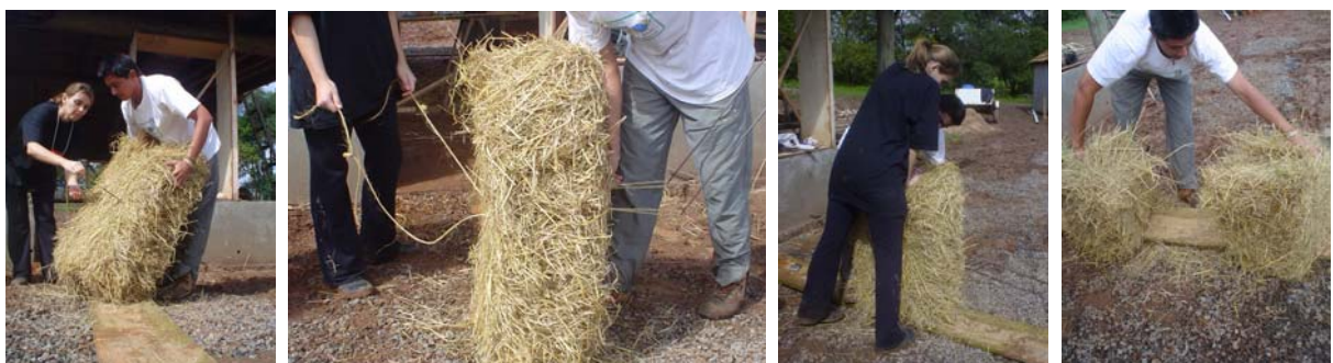
Figura 34: processo de corte dos fardos (Fotos: Thalita Mazzilli, outubro 2005)
