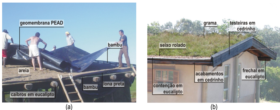
Figura 26: subsistema de cobertura (Fotos: (a) outubro 2005; (b) outubro 2006)
