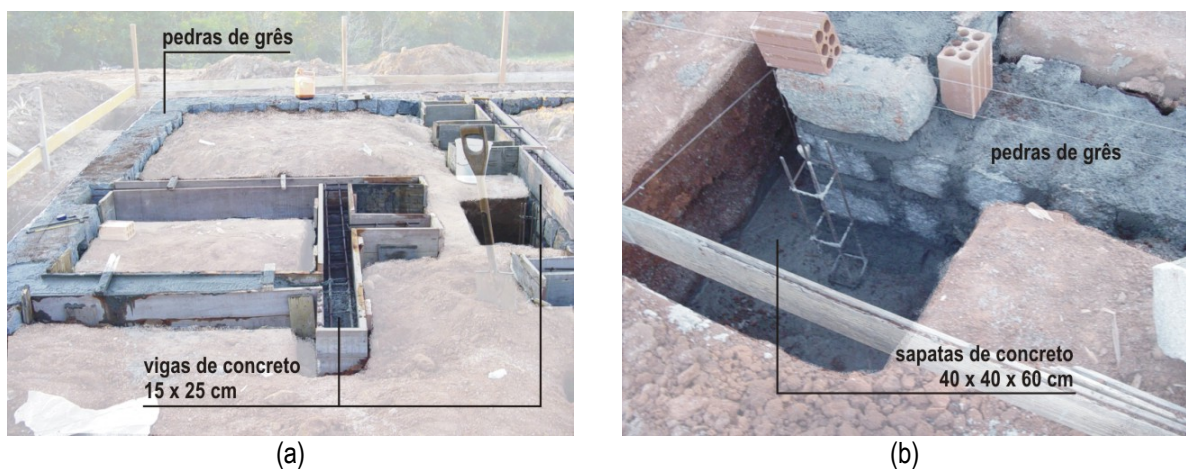
Figura 24: subsistema de fundações (Fotos (a) e (b): Helena Volkmann, julho 2005)
