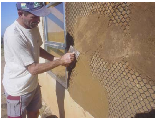
Figura 44: execução do revestimento externo com esterco de gado (Foto: junho 2006)
