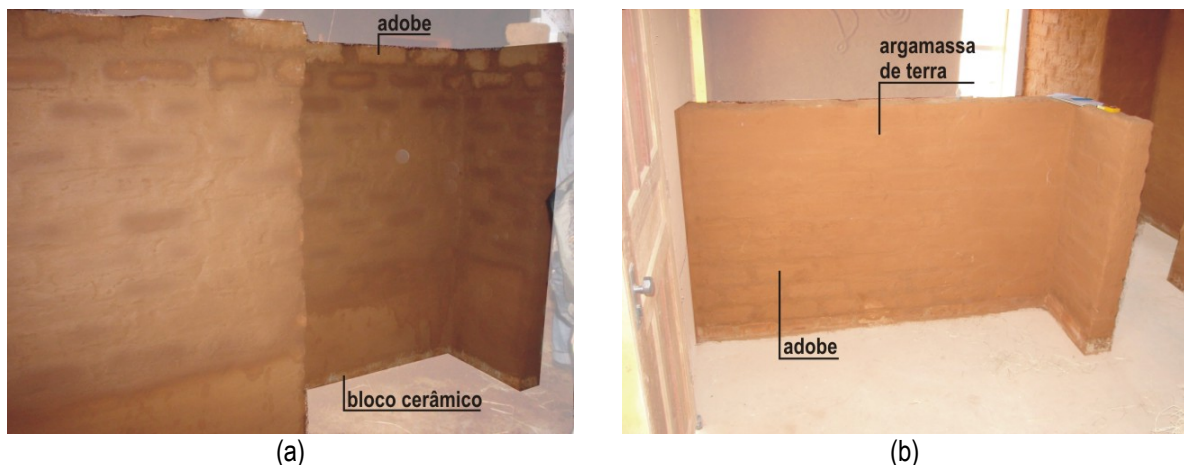
Figura 28: vedações internas executadas até o presente momento (Fotos (a) e (b): outubro 2006)
