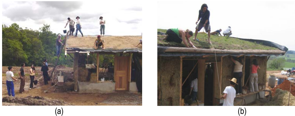
Figura 32: atividades de construção da cobertura verde (Fotos: (a) Helena Volkmann e (b) Ronaldo Rodrigues, outubro 2005)
