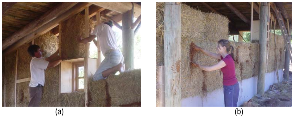
Figura 35: processo de construção das vedações externas (Fotos (a) e (b): outubro 2005)
