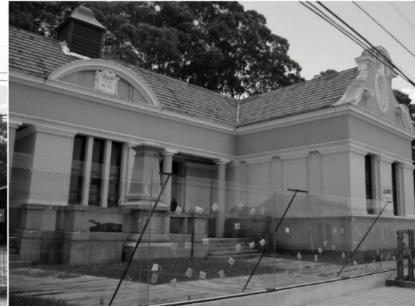
O Grupo Escolar Comendador Rheingantz - Edifício nº 188. Projetado pelo Escritório de R. Ahrons em 1911, em estilo maneirista alemão. Atualmente a edificação encontra-se em processo de restauro. Fonte: a autora, dez/2013.
