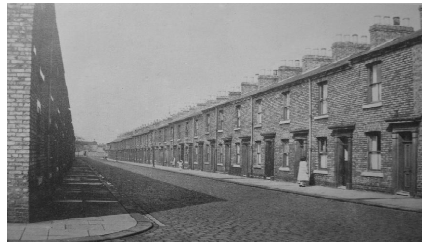
Figura 16: Um dos bairros operários ingleses construídos, com unidades habitacionais para serem alugadas. Foi edificado conforme os regulamentos de 1875, que previam forte padronização e uniformidade.
