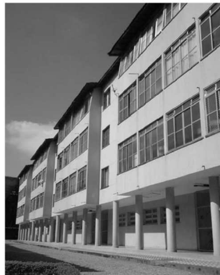
Liberação parcial do pavimento térreo através do emprego de pilotis nos edifícios do Conjunto Residencial da Mooca. Percebe-se a privatização de áreas térreas através de gradis, que passam, então, a controlar o acesso aos apartamentos. Fonte: Fotos de Camila Ferrari. Jun/2010.
