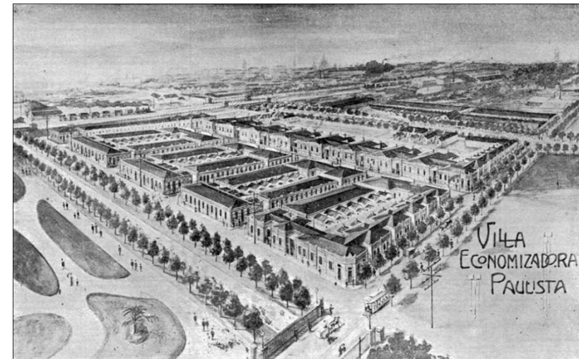
Figura 27: Perspectiva da Vila Economizadora (1908 -1910), edificada pela Companhia Economizadora Paulista, no Bairro da Luz, em São Paulo. Fonte: < www.saopauloantiga.com.br >. Acesso em maio/2014.
