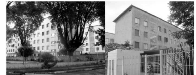
Fachada de edificação composta por dois módulos por pavimento. Fonte: BONDUKI, Nabil. Artigo Análise Tipológica da Produção de Habitação Econômica no Brasil (1930-1964). Apresentado do Documomo 5.
