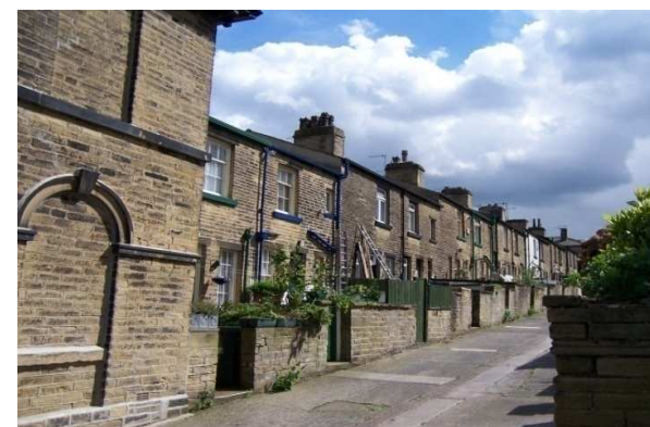
Figura 13: Imagem das unidades habitacionais operárias de Saltire.
