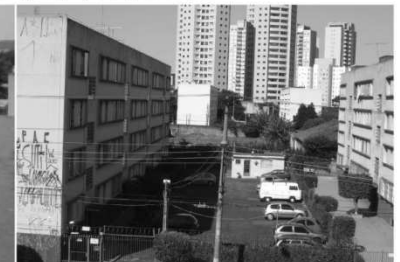
Os interstícios de espaços abertos entre os blocos habitacionais de quatro pavimentos, que, atualmente utilizados como estacionamento para veículos. Fonte: Foto de Isabela Belém Meneghelo, 2006.
