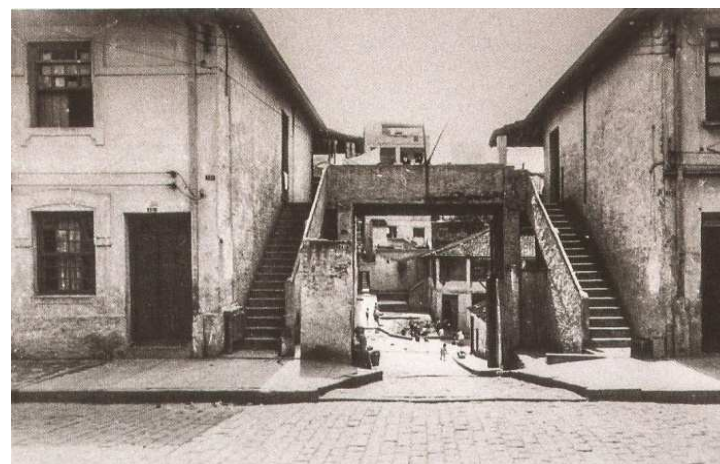
Figura 20: O Vaticano, um casarão que foi transformado em casa de cômodos em 1982, época em que foi demolido. Foi uma das edificações a resistir por mais tempo às mudanças exigidas pela cidade/sociedade do século XX.
