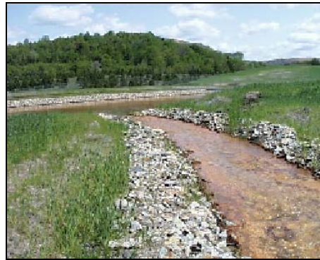
Figura 6 Canal calcário óxico (Fonte: OSM, 2006)
