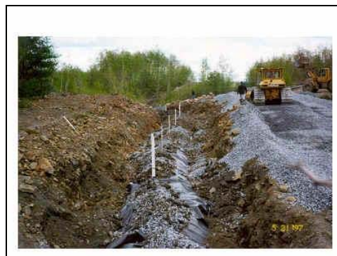
Figura 7 Dreno calcário anóxico (Fonte: OSM, 2006)
