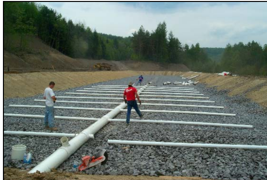
Figura 8 BFV em construção (Fonte: OSM, 2006)
