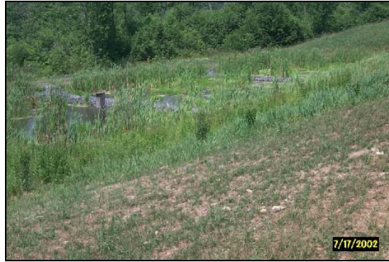
Figura 5 Lagoa anaeróbica (Fonte: OSM, 2006)
