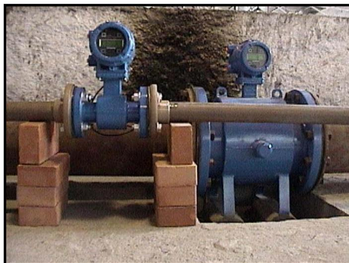
Fig. 4.22 - Medidores de vazão eletromagnéticos.
