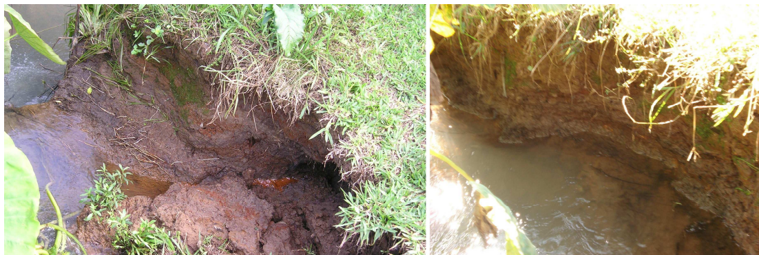
Figura 6.11. Colapso de margens e erosão no fundo do canal de drenagem na bacia de Arvorezinha após a adoção de práticas de conservação de solo nas lavouras.
