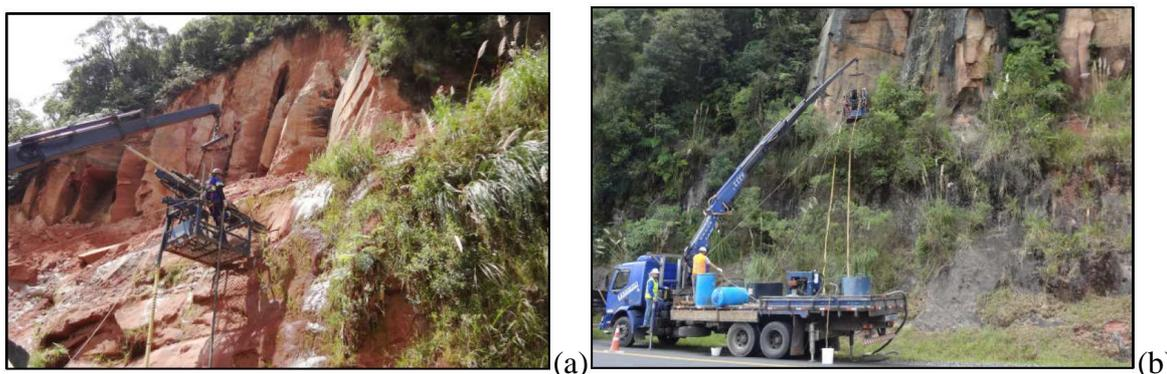
**Figura 47. (a) imagem da perfuração para a instalação do grampo junto a Formação Rio do Rastro (km 108+500) e (b) imagem da perfuração junto a Formação Botucatu (km 108+565).**
