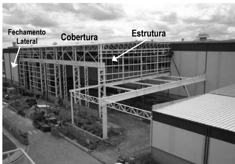
Figura 5-27: Sistema metálico - empreendimento C
