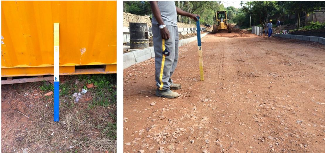
Figura 25 e 26 – À direita e à esquerda, ferramenta de poka-yoke implantada para evitar os erros de cota e espessura na aplicação de brita graduada.
