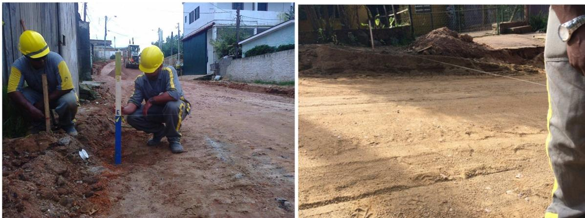
Figura 23 e 24 – À direita e à esquerda, exemplos de utilização de poka-yoke para evitar os erros de cota no greide de terraplenagem final da pista.
