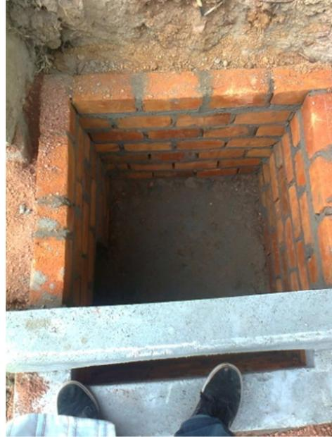
Figura 04 e 05 - À esquerda: rede de drenagem. À direita: caixa de alvenaria em execução
