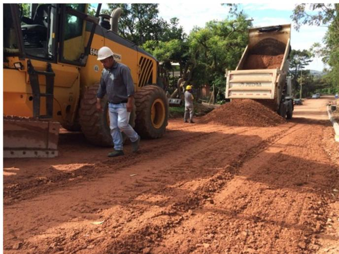
Figura 32 – Brita graduada sendo descarregada e aplicada diretamente na pista
