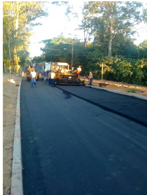
Figuras 08 e 09 – Execução de meio fio em concreto, espalhamento de brita graduada e lançamento da capa asfáltica final
