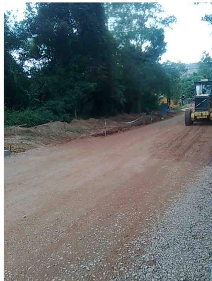
Figuras 06 e figura 07 – À esquerda: escavação da caixa da rua. À direita: regularização de subleito em andamento.
