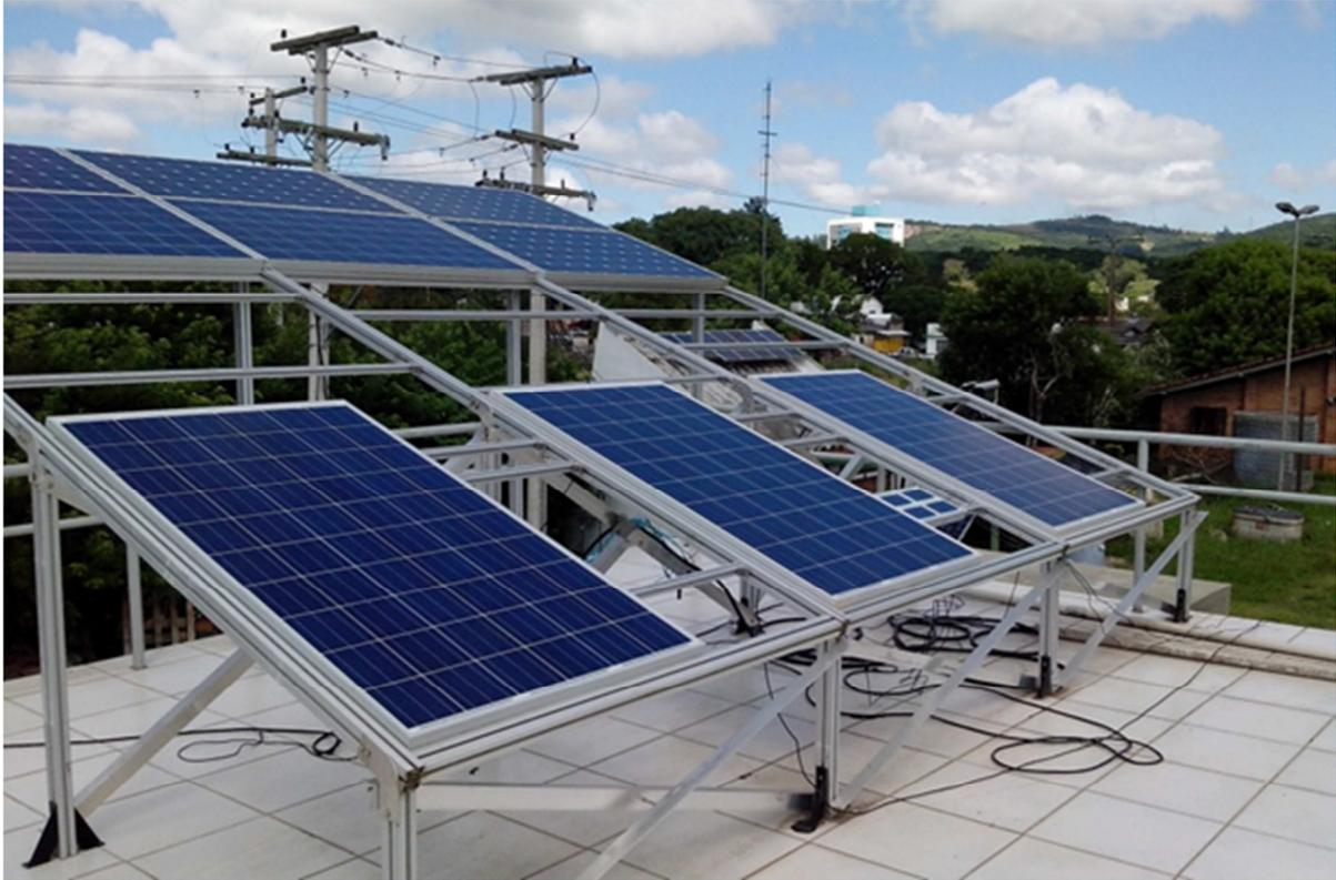
Figura 5.1 – Instalação da série de módulos usada para testes (3 módulos da fileira inferior).
