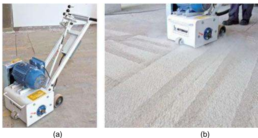
Figura 6 - (a) Máquina fresadora. (b) Aparência da laje após fresamento.
