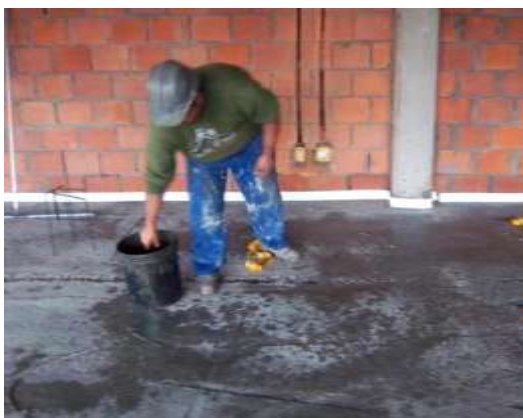
Figura 8 - Umedecimento da laje.
