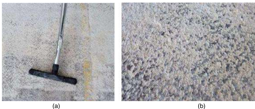
Figura 7 - (a) Aplicação do primer na laje. (b) Aparência da laje após fresamento e aplicação de "primer". Fonte: (CICHINELLI, 2013)
