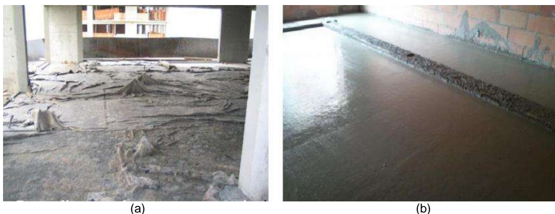
Figura 16 - (a) Cura do contrapiso com cobrimento e umedecimento superficial; b) Cura do contrapiso ao ar livre. Fonte: (BARROS, 2013) e (SILVA, 2013)
