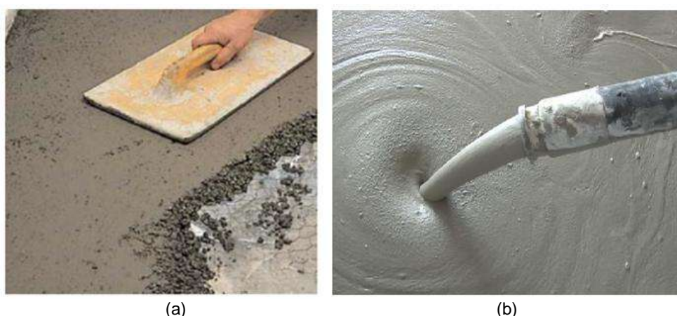
Figura 2 - (a) Aplicação da argamassa de contrapiso dosada em obra; (b) Aplicação da argamassa de contrapiso autonivelante.
