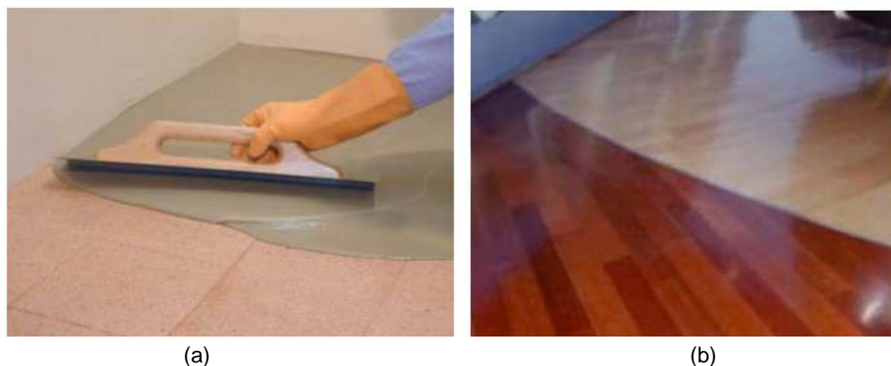
Figura 17 - (a) Argamassa autonivelante sendo aplicada (com espátula) sobre piso cerâmico; (b) Aplicação de argamassa autonivelante sobre revestimento de madeira.
