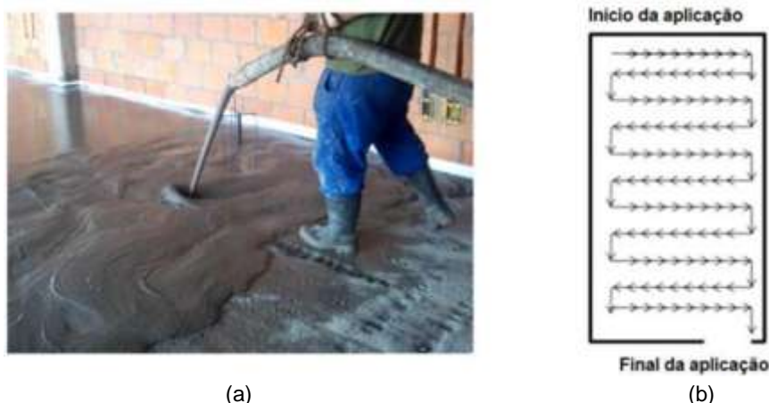
Figura 10 - (a) Lançamento da argamassa autonivelante; (b) Esquema de aplicação da argamassa no ambiente; Fonte: ((b) - GUGELMIN, 2013)
