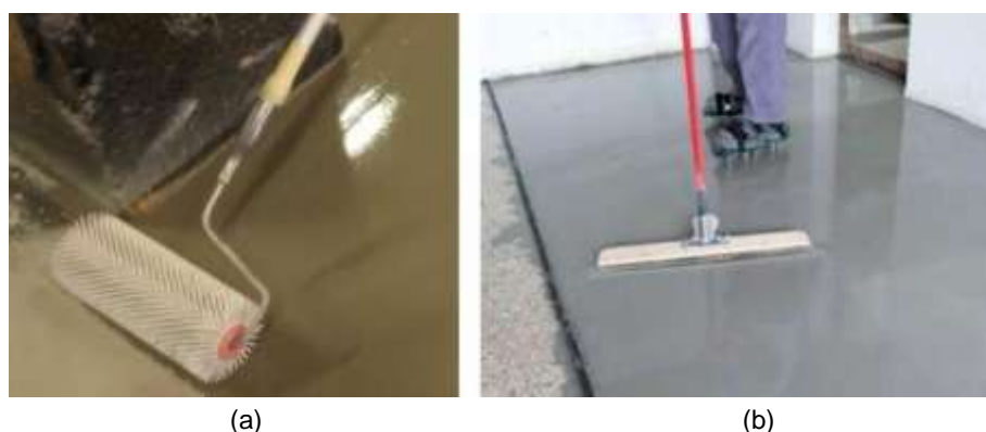
Figura 14 - (a) rolo quebra bolhas sendo aplicado na argamassa autonivelante; (b) rodo dentado sendo aplicado na argamassa
