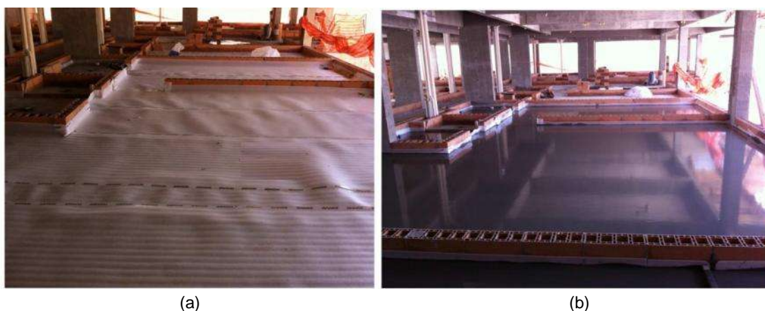
Figura 5 - (a) Pavimento com colocação de manta acústica, para receber contrapiso autonivelante; (b) Pavimento com aplicação de contrapiso autonivelante, sobre manta acústica.
