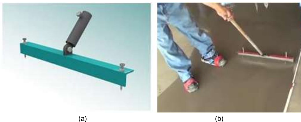
Figura 12 - (a) Rodo nivelador; (b) Rodo nivelador sendo aplicado em contrapiso de argamassa autonivelante. Fonte: (DUPOL, s.d.) e (SILVA, 2010)
