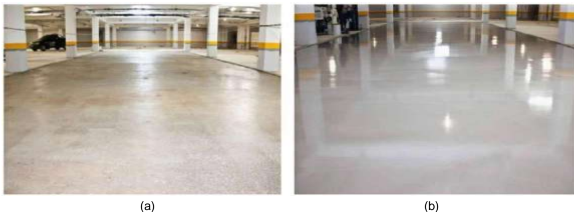
Figura 4 - (a) Área de estacionamento pronta para receber o contrapiso autonivelante industrial; (b) Área de estacionamento com o contrapiso autonivelante industrial aplicado.
