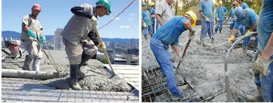
Figura 19: Tráfego sobre laje durante a concretagem (Fonte: Equipe de Obra).
