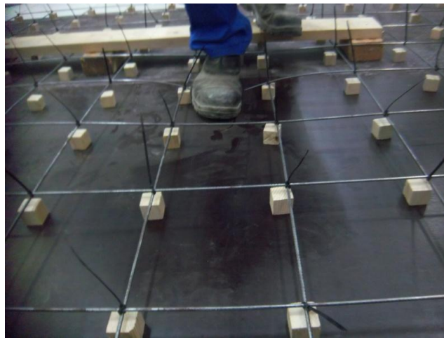
Figura 52: Aplicação de carga sobre malha diâmetro 4,2 mm e contato armadura/fôrma
