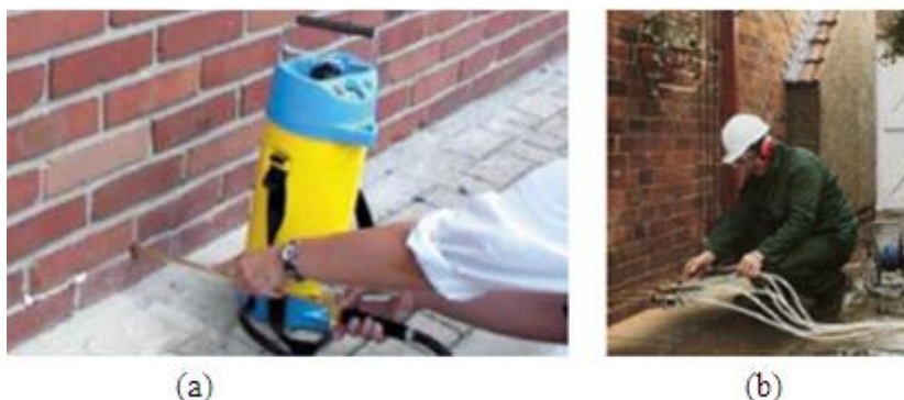
Figura 31 - Aplicação por injeção: (a) equipamento de injeção; (b) execução da injeção. Fonte: Teixeira 2007.
