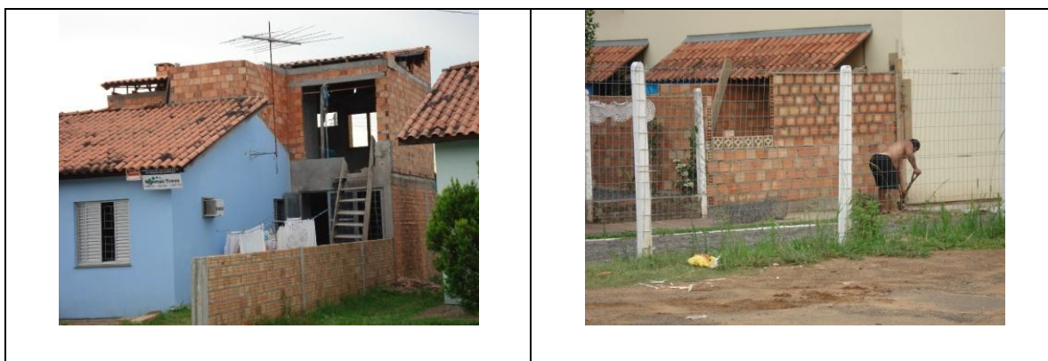
Figura 14 - Modificação da unidade habitacional sem a devida autorização
