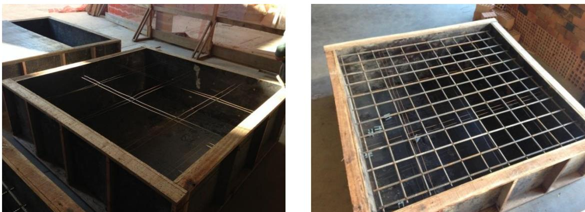
Figura 18 – Fôrmas para concretagem das paredes.
