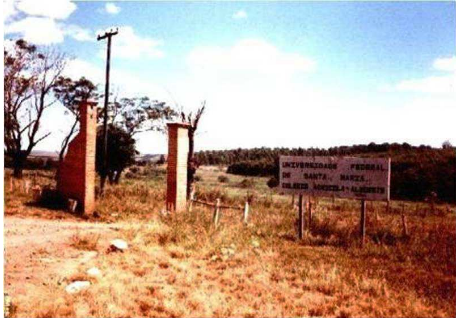
Figura 1 - Pórtico de entrada da escola, década de 60.
