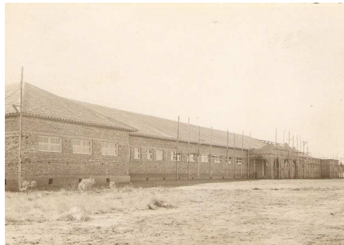
Figura 2 – Construção do primeiro prédio da Escola
