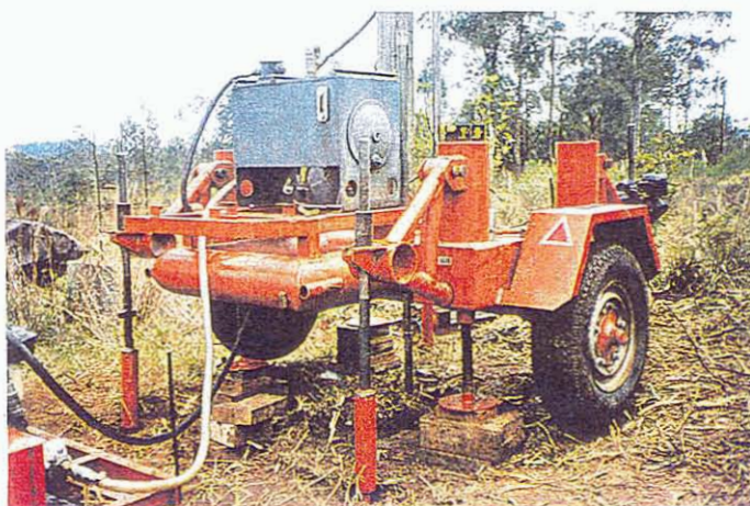
Figura 6.41 - Detalhes da ancoragem e sapatas de apoio.
