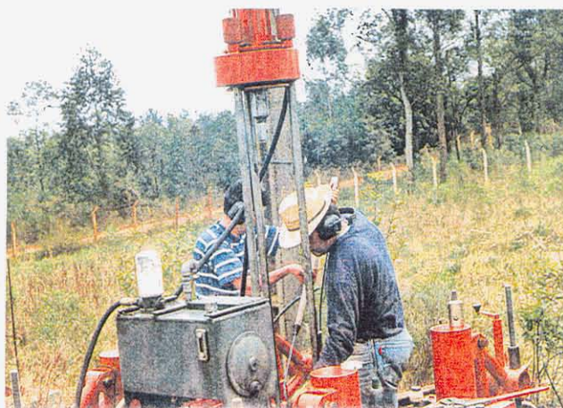
Figura 6.45 - Colocação de haste de cravação
