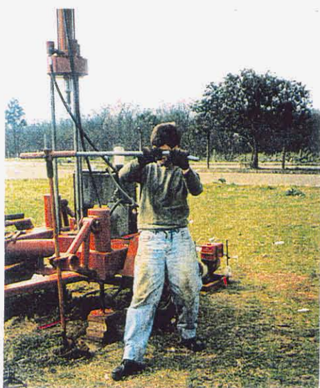
Figura 6.42 - Fixação de ancoragem
