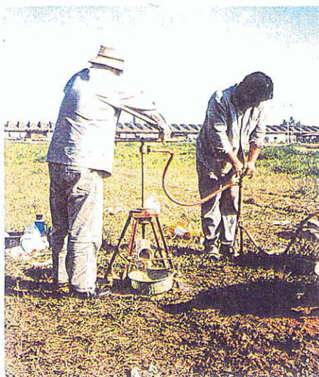
Figura 6.16 - Execução de furo em argila mole.
