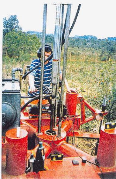
Figura 6.44 - Ensaio em andamento
