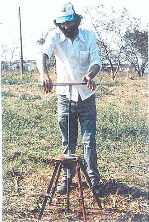
Figura 6.15 - Execução de furo em solo firme.
