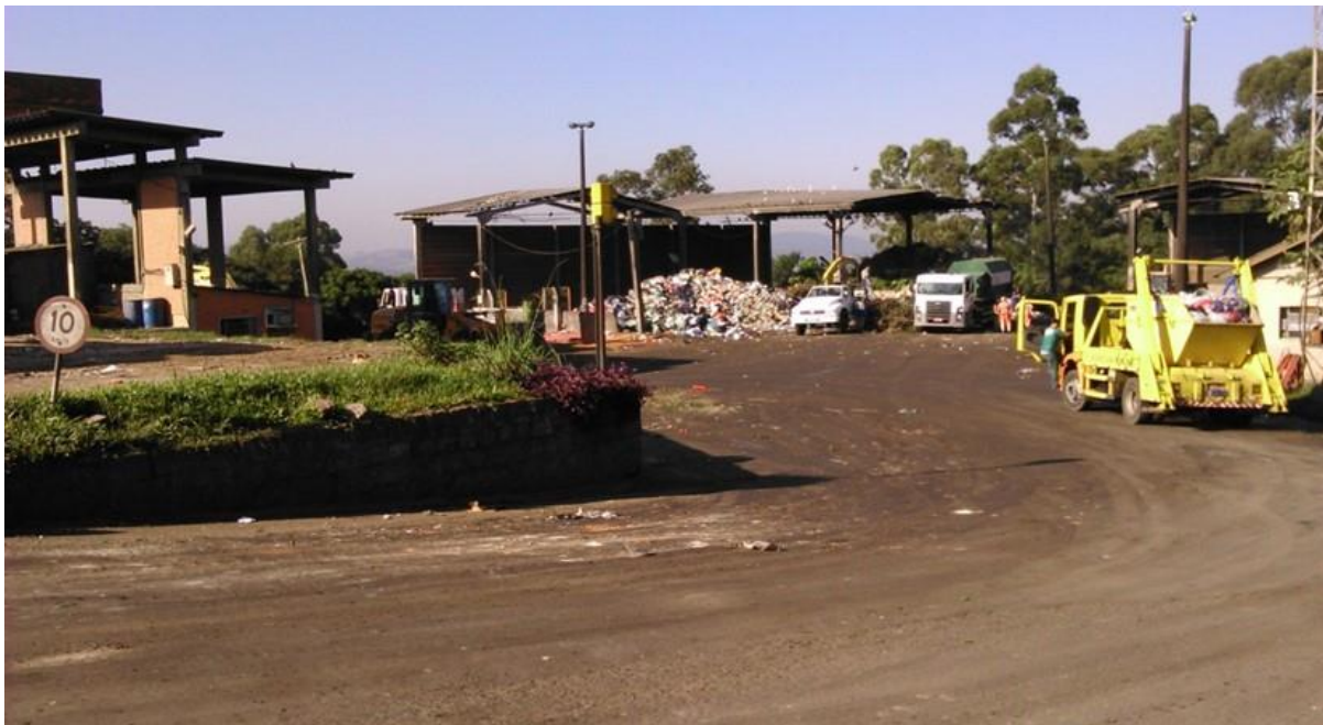
Figura 6: Entrada da Estação de Transbordo Lomba do Pinheiro, local de trabalho do pessoal do DMLU, 2014. (foto: Helisa Canfield).
