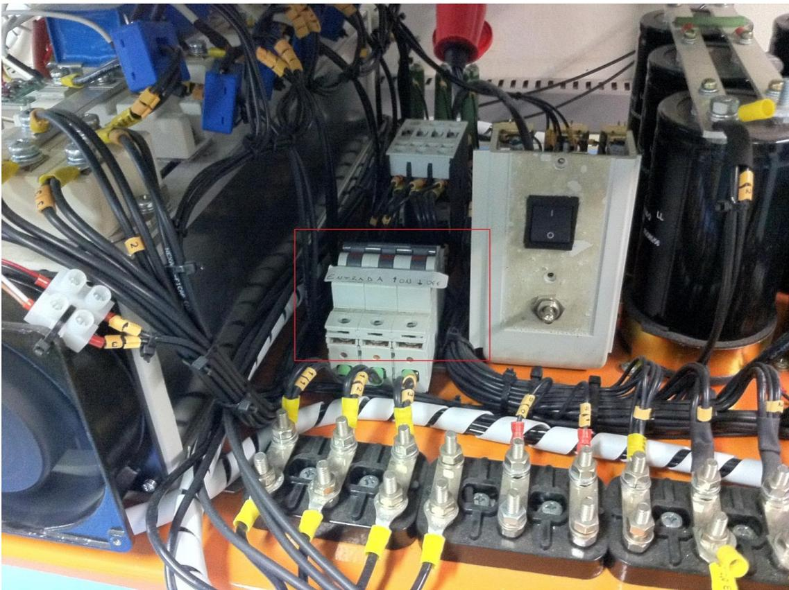
Figura D.3: Disjuntor trifásico da entrada do inversor pentafásico.
