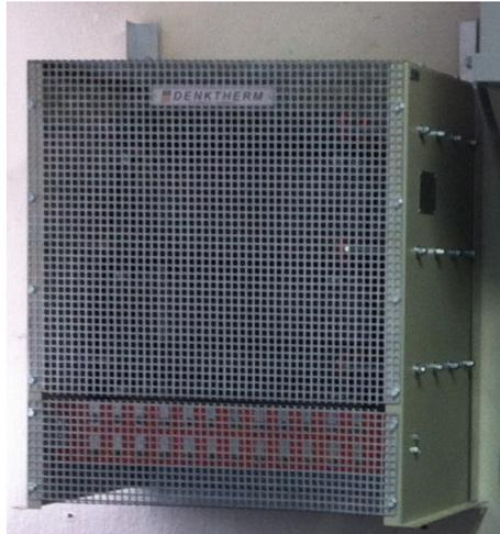
Figura 3.8: Banco de cargas resistivas formado por 12 resistores de  $80 \Omega$ .
