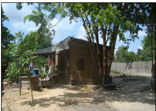
Habitação de Barro de Produtor na Ilha de Mosqueiro
