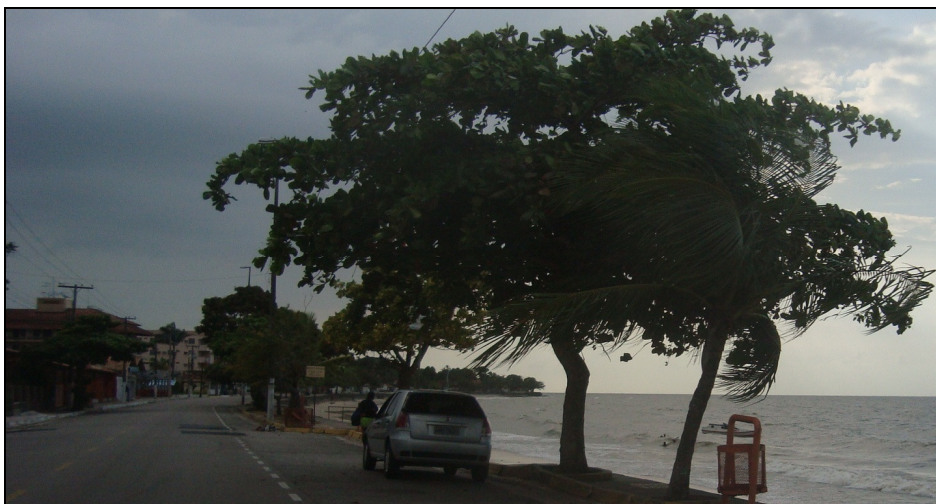
Figura 40: Edificações na beira da praia, na Ilha de Mosqueiro
