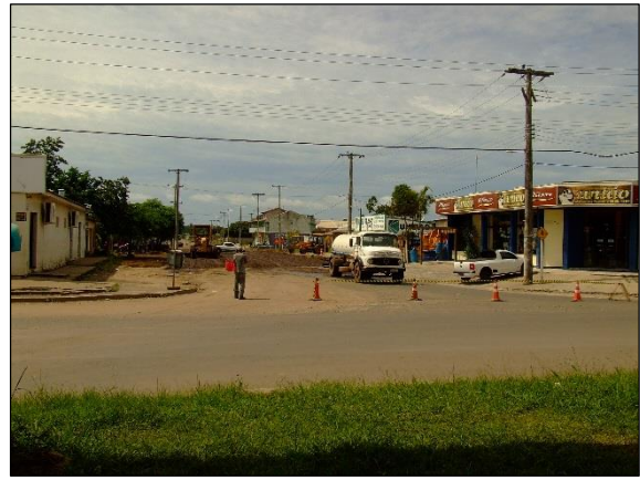
Figura 11 – Pavimentação da rua Alberto Pasqualine, em 26/02/2015.
