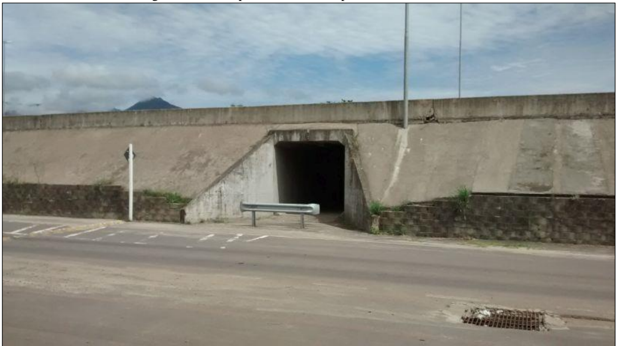
Figura 13 – Vista para a travessia de pedestres sob a BR-101.
