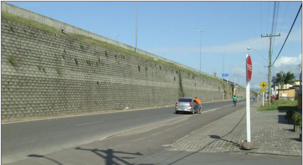
Figura 12 – Vista para passagem elevada da BR-101 na área urbana de Terra de Areia
