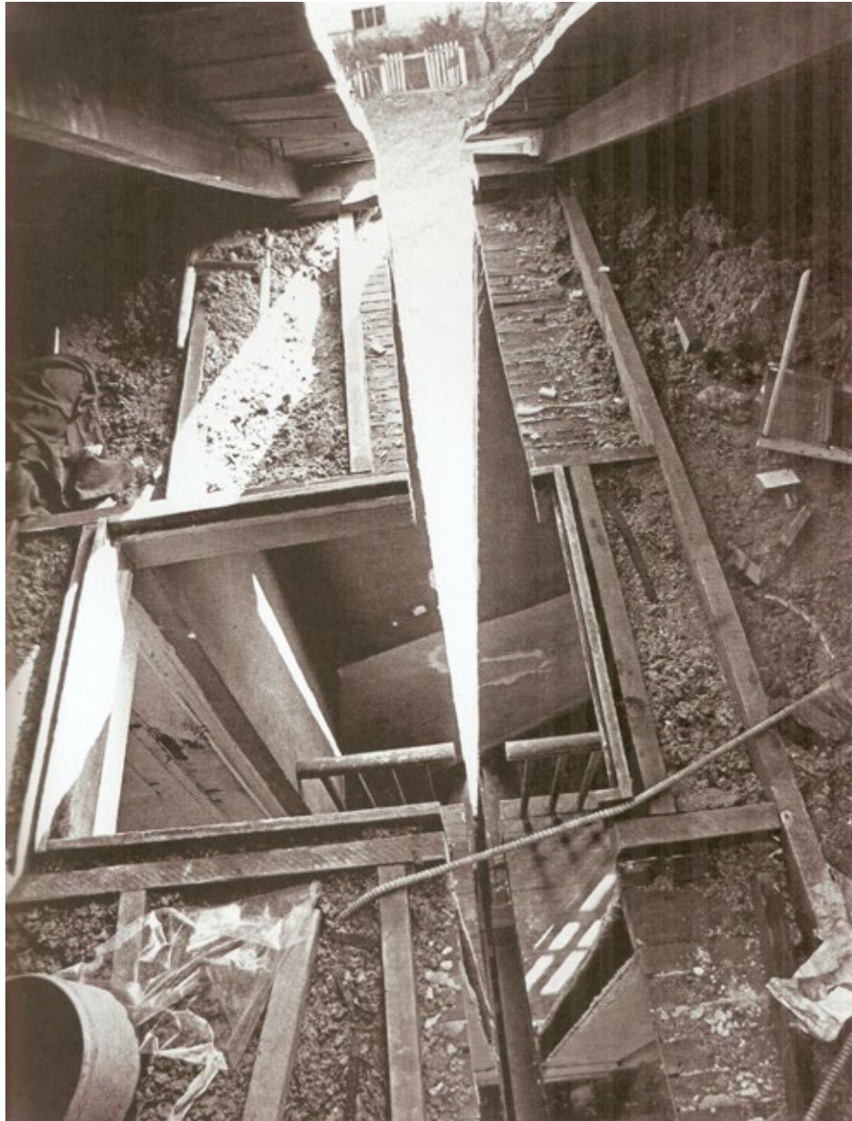
FIG. 134 - Splitting 7 , interior. Matta-Clark, 1974. Nas mãos de Matta-Clark as edificações dariam seu último suspiro de forma poética, antes de serem demolidas. Fonte: DIS-ERENS, 2003.
