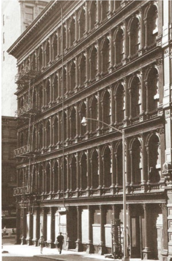
FIG. 50 - Haughwout Building, construída em 1857 utilizando diversas partes pré-fabricadas em ferro fundido. Típica edificação da Era Industrial de Manhattan, 1964. Fonte: Fred W. McDarrah, New York, NY
