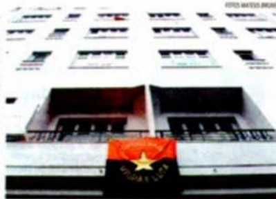
Prédio abandonado foi invadido e se tornou exemplo de luta pela moradia
