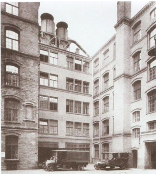
FIG. 34 - Pátio interno da F. W. Muller Factory, no início do século XX. Fonte: GÓMEZ; KRAMER, 2003.
