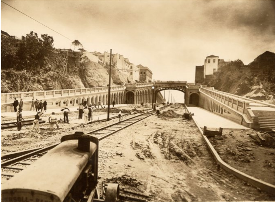
FIG. 152 - O Viaduto Otávio Rocha em obras, anos 1920. Fonte: Museu Joaquim Felizardo
