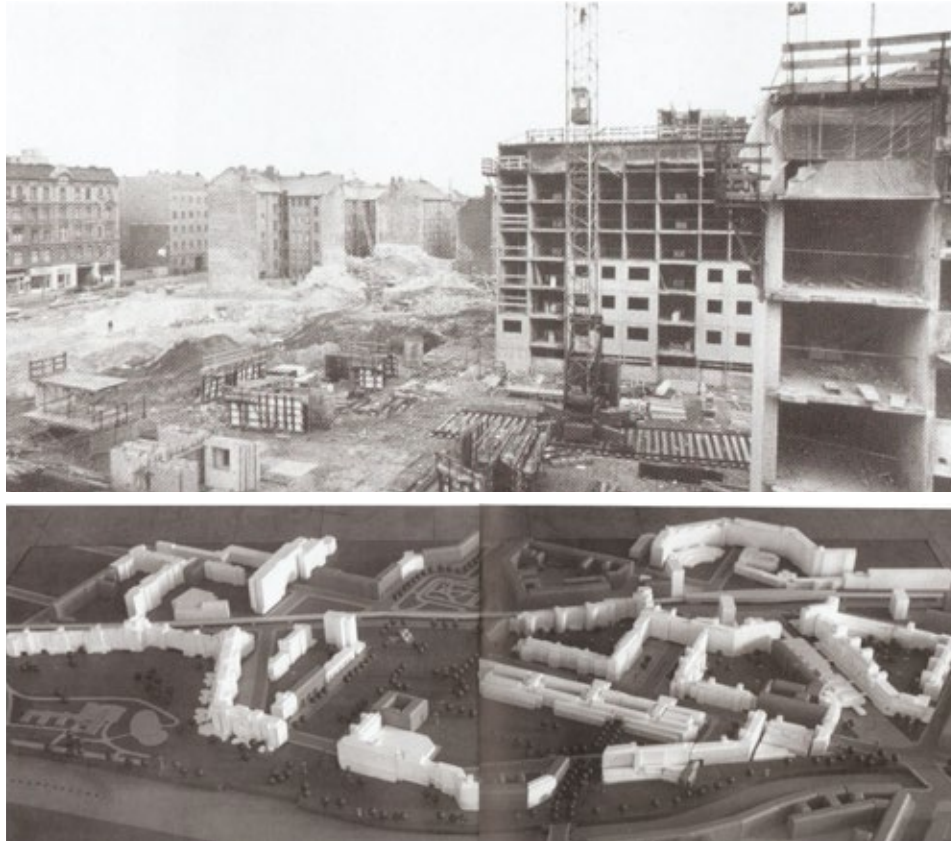
FIG. 31 e 32 - Kreuzberg e os projetos que visavam uma renovação urbanística da área, com a demolição de diversas edificações, algumas em estado parcial de ruína. A falta de recursos impossibilitou que muitos destes projetos saíssem do papel e, em decorrência disto, o Movimento Squatter entrou em cena, quando milhares de jovens passaram a ocupar diversas edificações abandonadas. Fonte: GÓMEZ; KRAMER, 2003.
