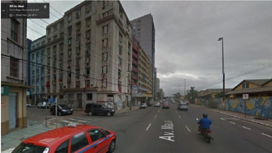
FIG. 9 - A edificação, na esquina da rua Caldas Júniors com a Av. Mauá, em Porto Alegre, foi palco de diversas ocupações de resistência, de populares organizados por um movimento social de luta pela moradia urbana. A partir da última destas ocupações, nomeada Ocupação Sarafá, as famílias aguardam agora a legalização da sua situação, ou a ocupação formal da edificação, bem como a reforma da mesma. Fonte: Google, 2015.
