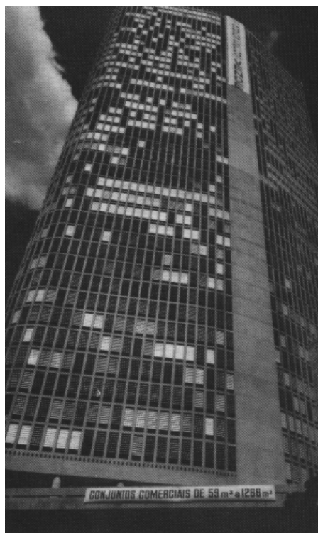
FIGURA 29 Adolf Franz Heep Edifício Itália, 1956.
