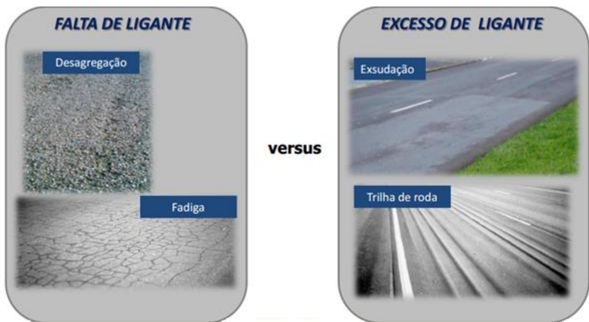
Figura 19: Demonstração da importância da dosagem adequada (adaptado de OHL BRASIL)
