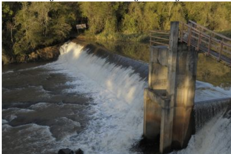
Figura 19 - PCH com tecnologia a "fio d'água".
