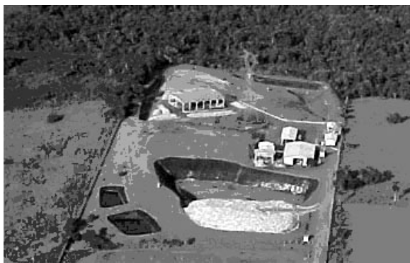
FIG. 56 – VISTA AÉREA DO ATERRO SANITARIO FONTE: PMCB, 2006
