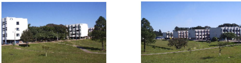
Figura 38: Unidades edificadas do Campus da UFSM.
