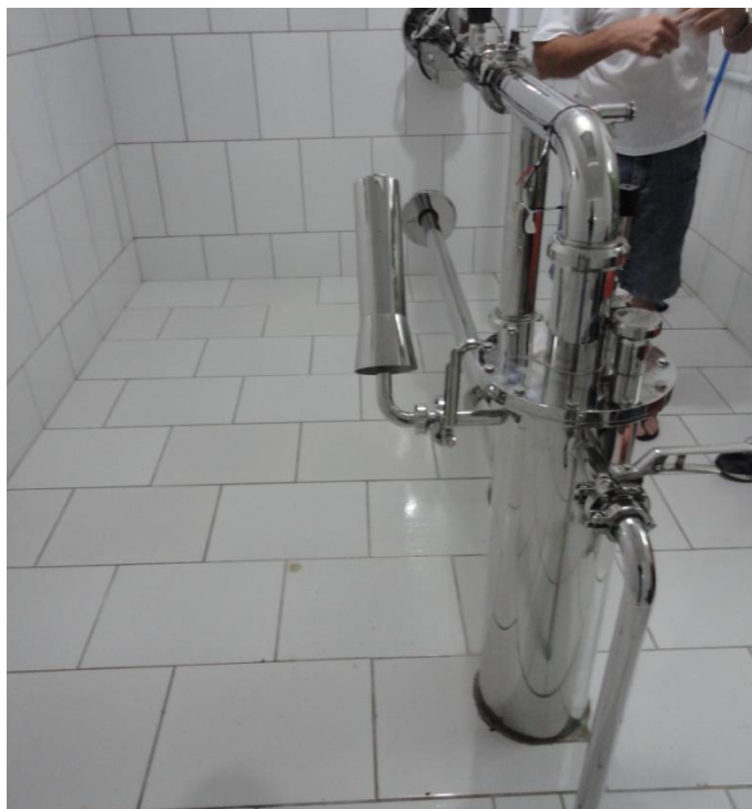
Figura 10- Poço do qual é extraída a água termal que abastece o Thermas Ilha Redonda.
