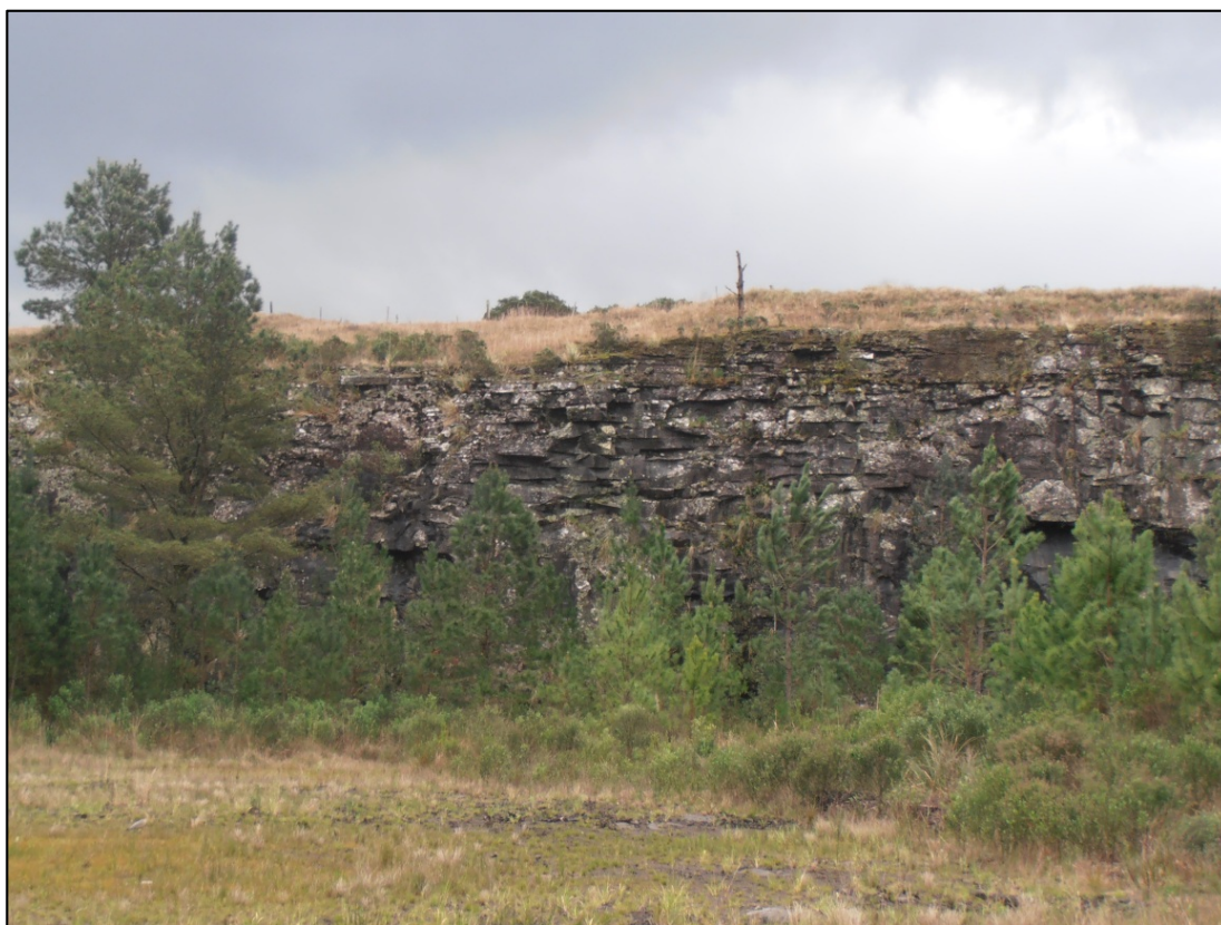
Figura 3 - Descontinuidades horizontais em derrame dacítico de aproximadamente 30 metros de espessura em mina abandonada às margens da RS-235. Fonte: Freitas (2015).
