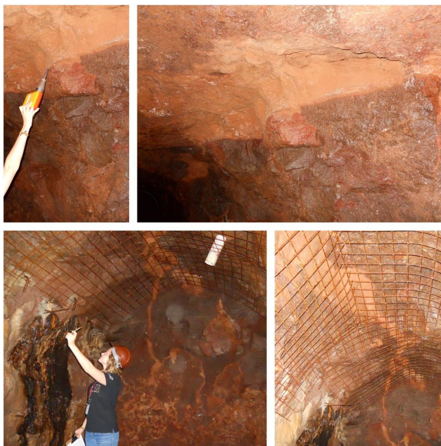
Imagem 9: As fotos superiores ilustram uma porção mais arenosa, as fotos inferiores mostram diques areníticos, ambas localizadas no túnel inferior direito.
