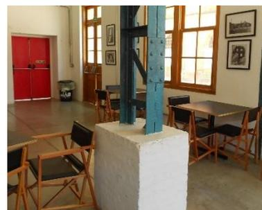
Fig. 156 Detalhe de um pilar-treliça restaurado.
