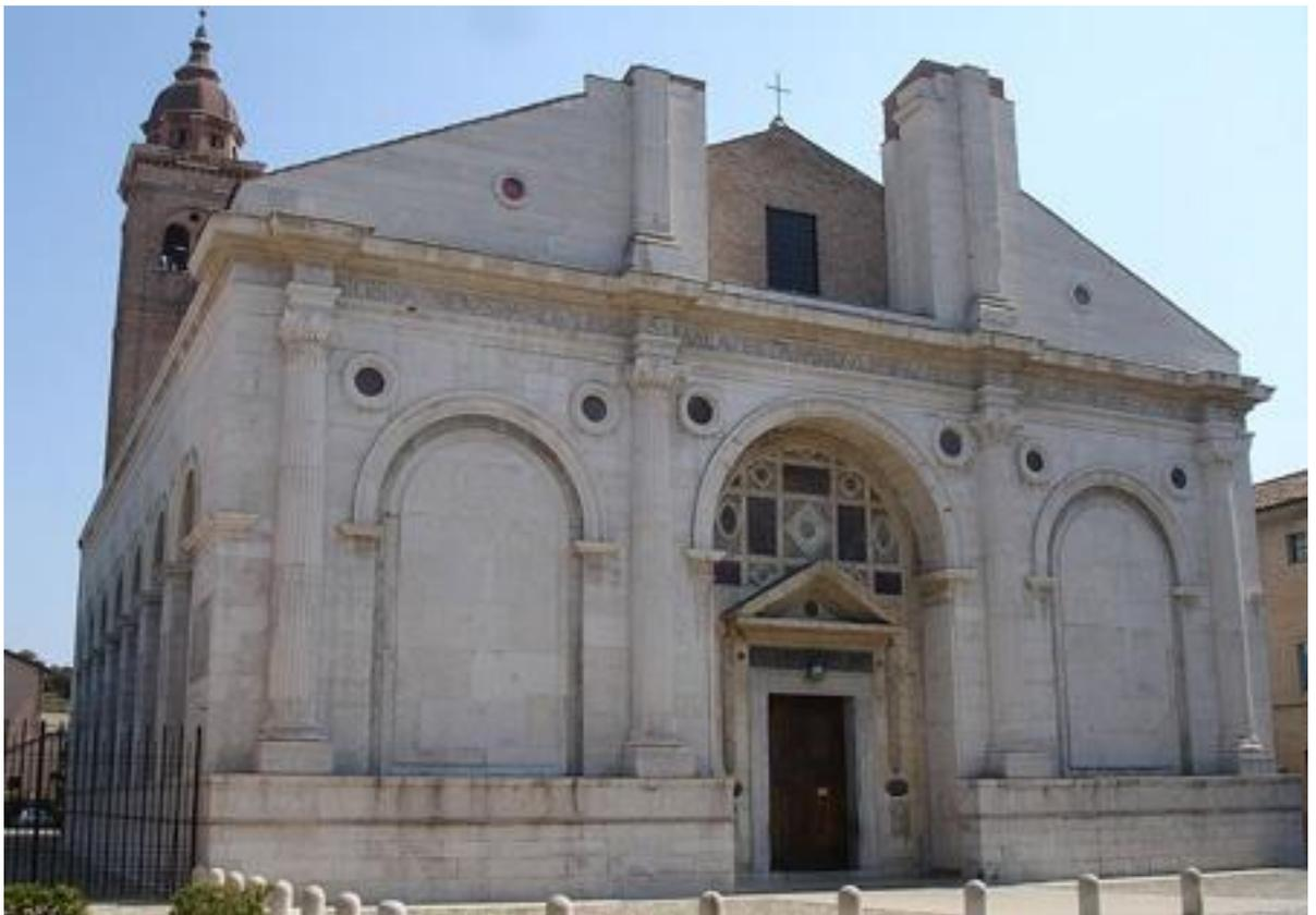
O projeto de Alberti previa o envelopamento da edificação por novas fachadas em pedra. O arquiteto iniciou a instalação de uma casca: uma nova espessura levemente afastada da igreja histórica. Nessa obra, assim como nas duas anteriores, Alberti realizou uma “delicada costura entre os elementos de tão distintas épocas, sem abrir mão da atualização necessária nem da continuidade histórica”.<sup>21</sup>
