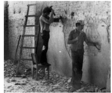
Fig. 95 Desnudamento das alvenarias rebocadas dos pavilhões.
