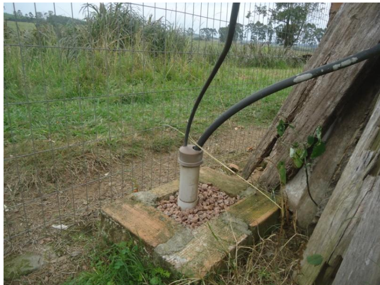
Figura 42 - Poço ponteira com sistema de bombeamento com compressor.
