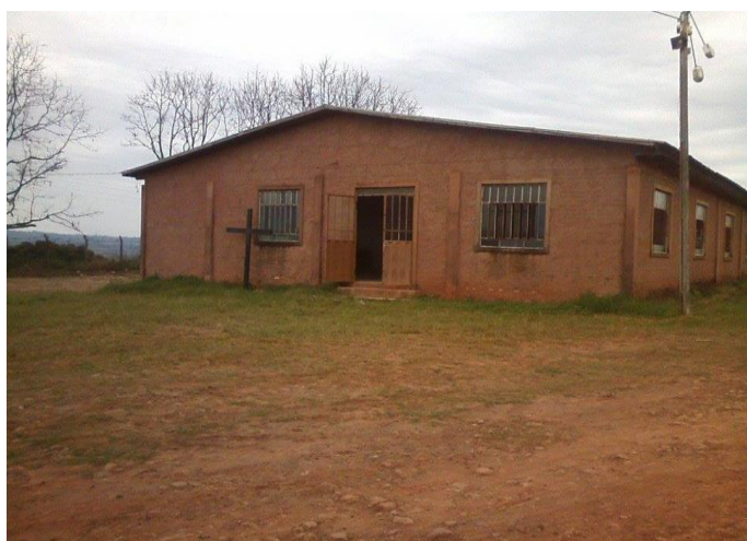
Figura 13. Salão paroquial na localidade Novo Horizonte. Jacuizinho/RS
