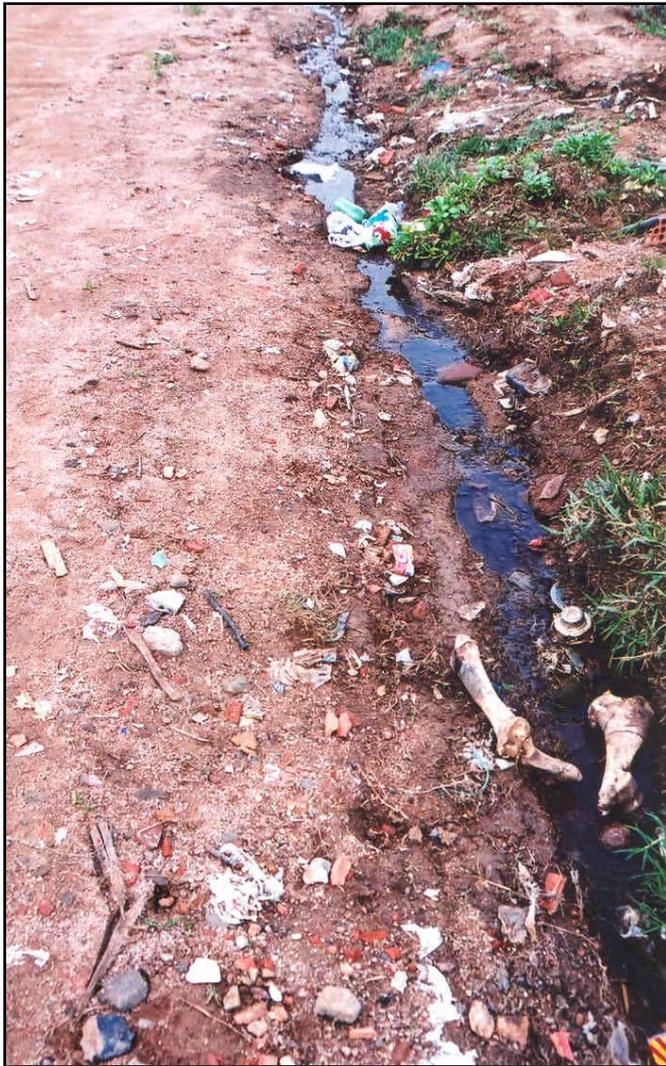
Figura 24 – Vala a céu aberto por onde escoa a chuva e também o esgotamento, evidenciado pela cor escura da água.
