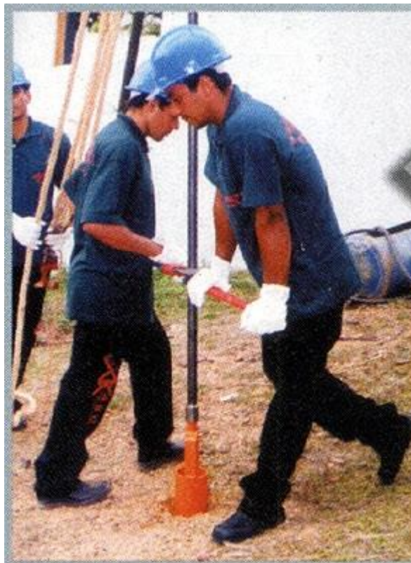
Figura 10 - Procedimento de Lavagem (ABEF, 2004)
