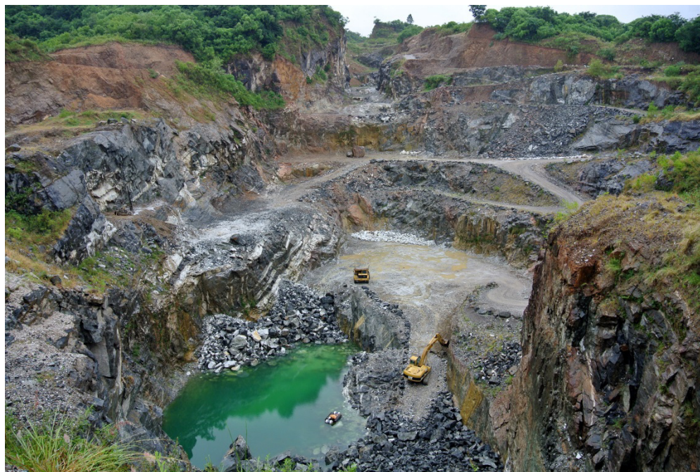
Figura 7: Visão geral da pedreira de mármore calcítico da empresa Mônego em Vila Nova do Sul.
