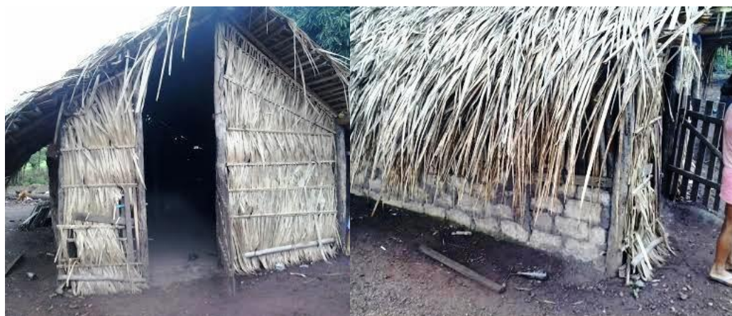
Figura 11 – Aspecto da casa feita de adobe e palha. Neste caso utilizada como cozinha no quintal de uma família da comunidade de Cascavel
