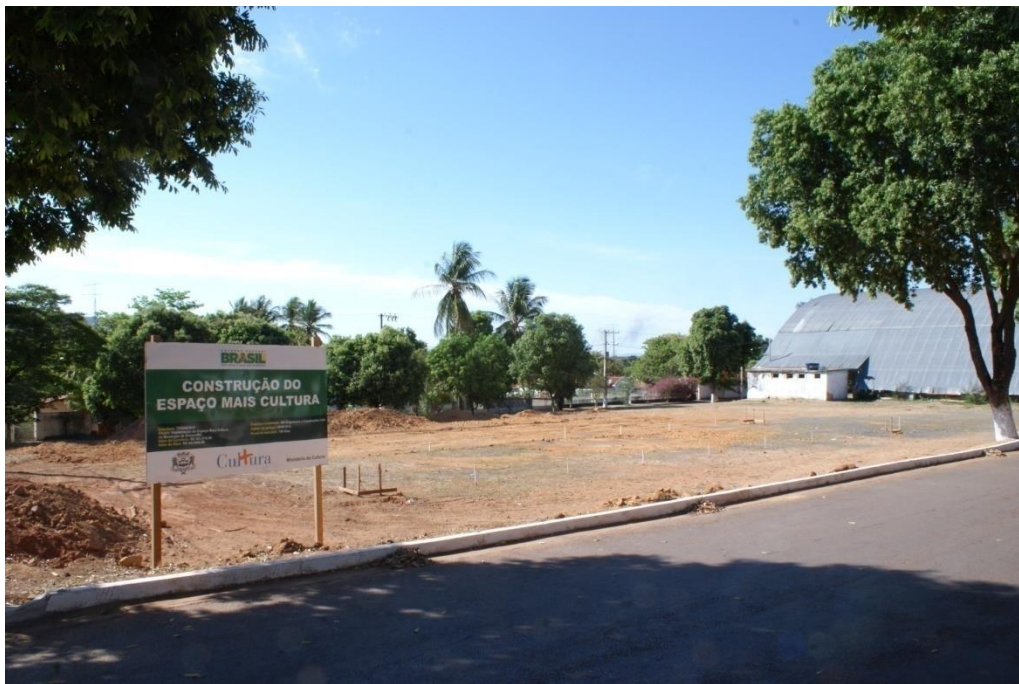
Figura 24 – Terraplanagem para recepção do “Espaço Mais Cultura” em Arinos, Minas Gerais, outubro de 2012
