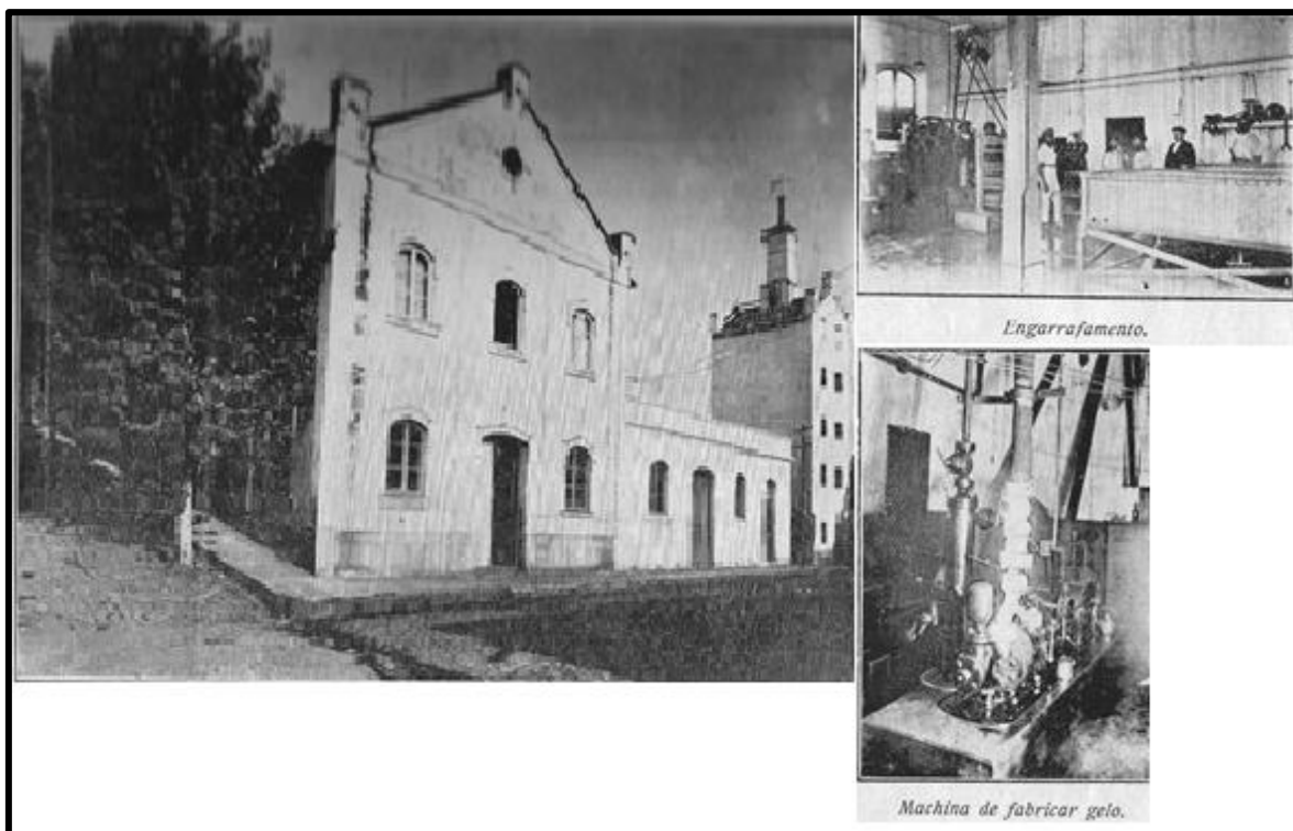
Figura 21: à esquerda, uma fotografia dos dois prédios da Cervejaria Estrella, localizada na esquina da Rua da Praia com a Rua Coronel Flores, à época em que ocupava apenas uma pequena parte da área de estudos.
