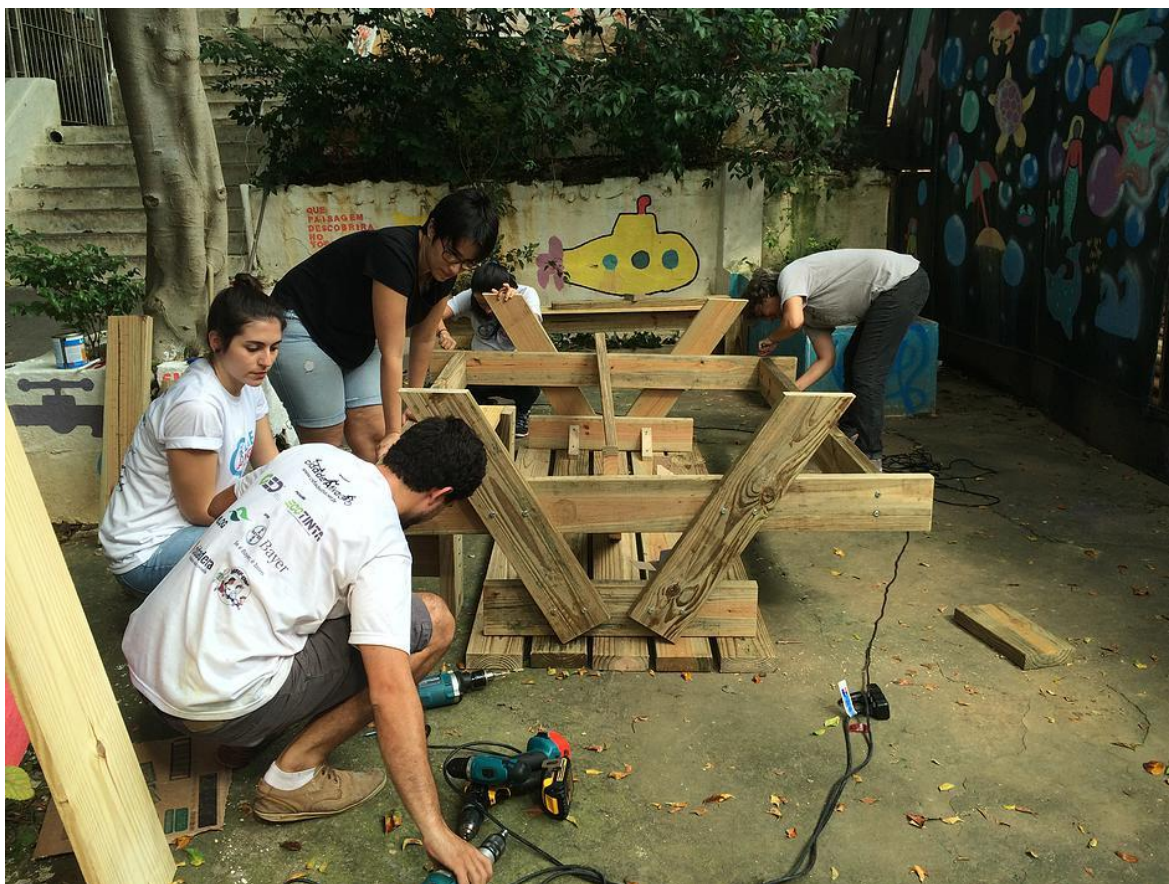
Figura 43 – Olhe o degrau: oficina de mobiliário urbano
